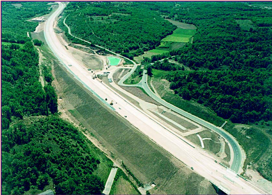
Fig. 3 - Grand remblai édifié avec zonage des matériaux (Photo Guintoli).
