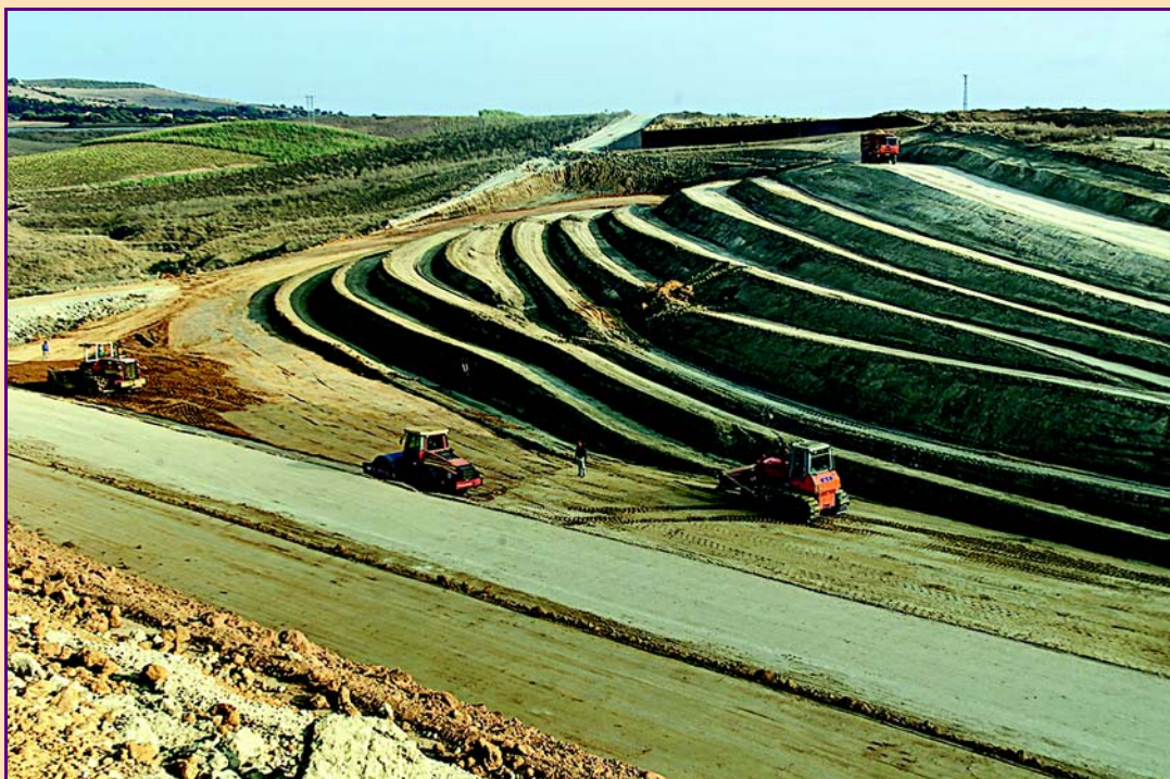
Fig. 4 - Redans au contact du sol de fondation en pente et d'un remblai (Photo ADM).
