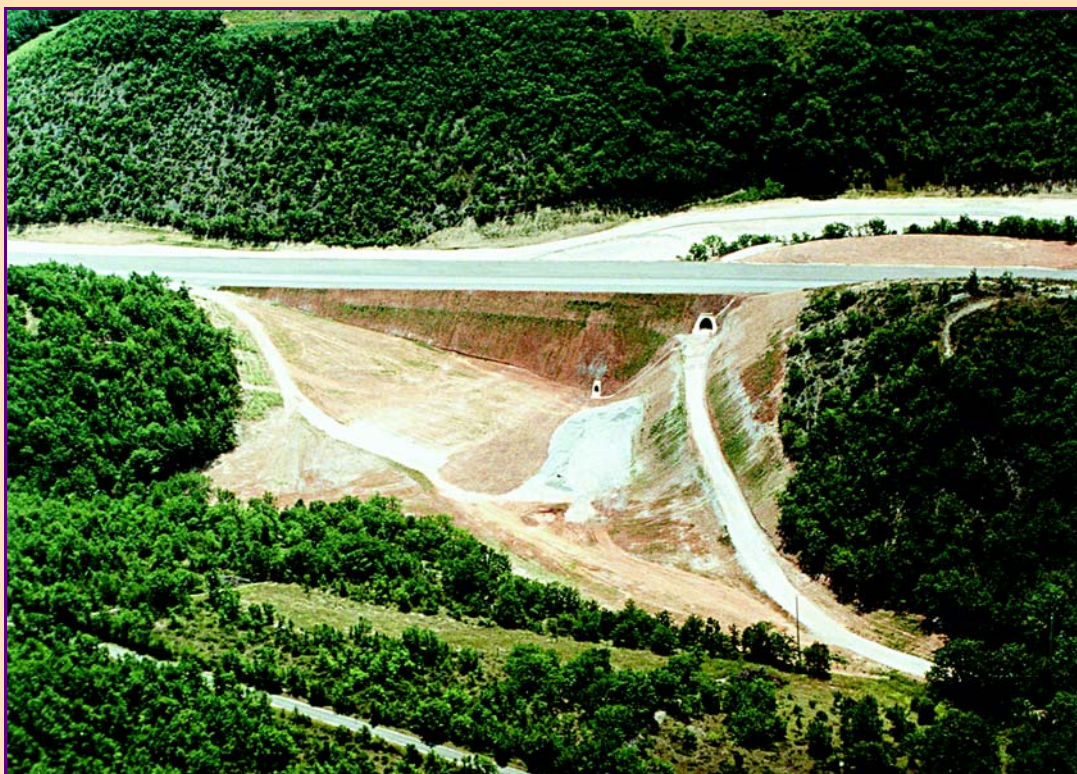
Fig. 6 - Exemple d'ouvrages transversaux dans un grand remblai (Photo Guintoli).
