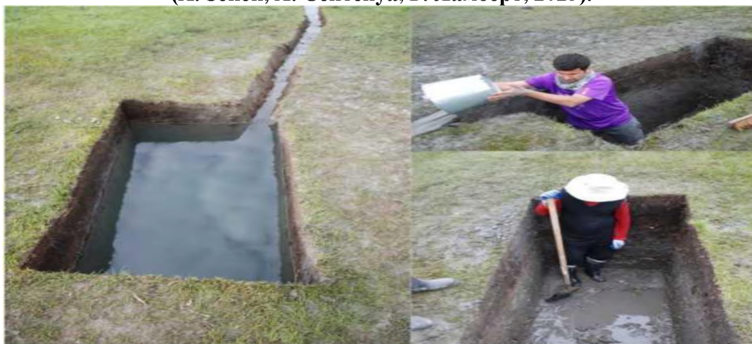
Рис.28. Рабочий момент откачка воды из траншеи.
