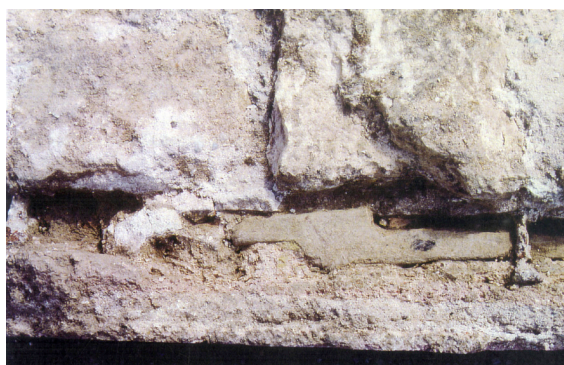
Figure 17 38-42, bd de la République, 1998. Exemple d'isolation dans l'architecture domestique : tegula cramponnée dans la maçonnerie d'un mur préalablement revêtu d'une couche d'enduit (L. Martin, Inrap).
