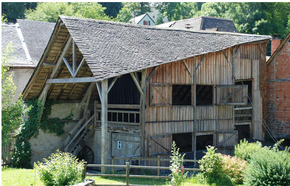
Batteuse hydraulique à Audressein : vue rapprochée de la façade au-dessus du canal avec ses ouvertures destinées à l'aération et son pont-levis.
