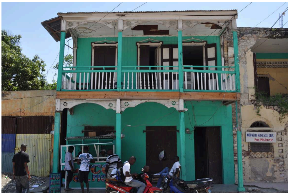
Maison Poulard, avenue de la Liberté. Cette maison de type « rez-de-chaussée en maçonnerie et étage en bois » conserve une partie des lambrequins en bois découpé d'origine de ses galeries, également en bois.
