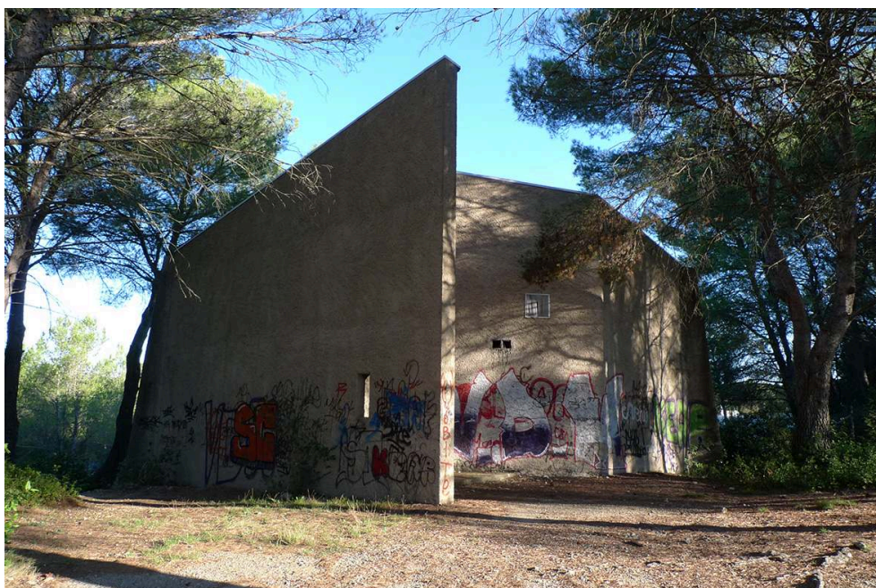
Cinéma Panorama à Clapiers : vue générale du côté de l'entrée du public : état actuel. Phot. Yvon Comte, 2011. © DRAC/CRMH LRMP.
