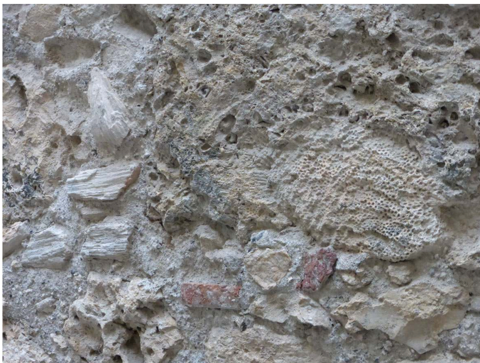
Détail de la maçonnerie en moellon de corail d'un mur de la prison.
