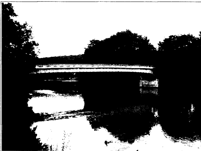
Fig. 5 - Photographie du pont de Luzancy.
