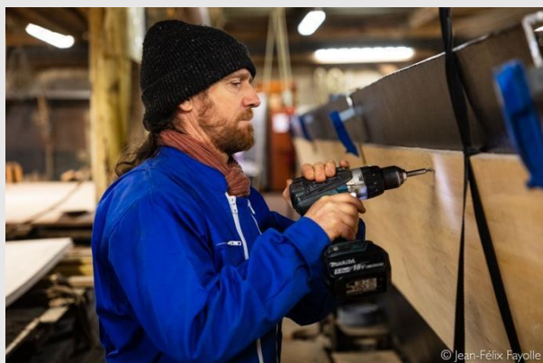
Habillage en bois d'une coque métallique. Association Boutavant, Tours (Indre-et-Loire). © Fayolle, Jean-Félix, 2024 (tous droits réservés).
