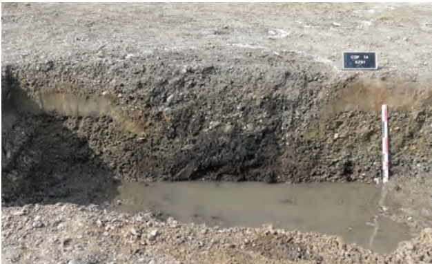
Fig. 28. Puits 6291 en cours de fouille. Apparition du cuvelage et montée de la nappe phréatique (cliché : L. Jammet-Reynal)
