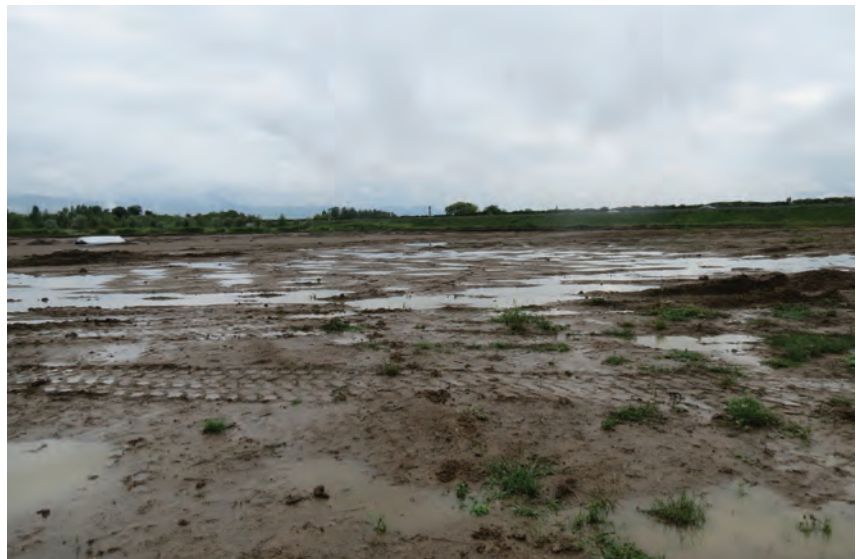
Fig. 11. Le chantier après la pluie (cliché : M. Roth-Zehner)
