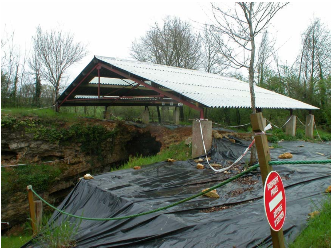
Fig. 2. En haut : travaux en cours lors du changement de la toiture protégeant le gisement au mois d'Octobre 2007. En bas : toiture entièrement terminée en Avril 2008
