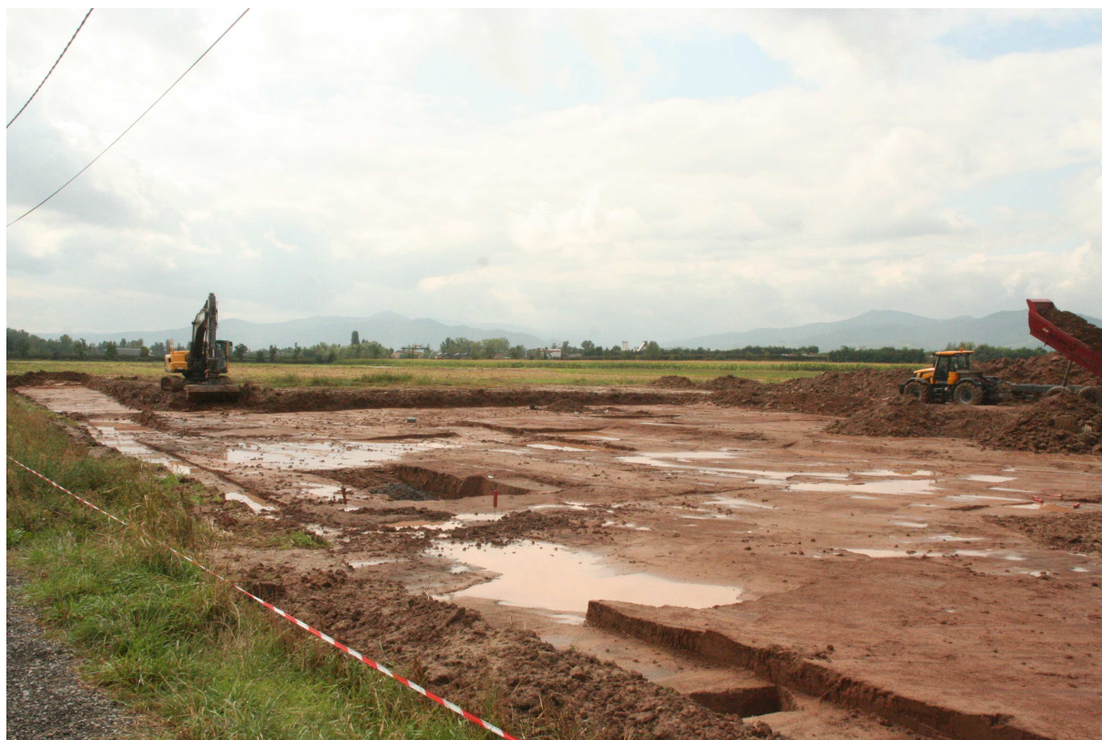
Cliché 1 – Houssen – Lotissement Le Château d'Eau : le chantier décapé après la pluie.
