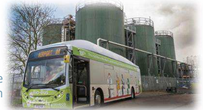
Usine de méthanisation
