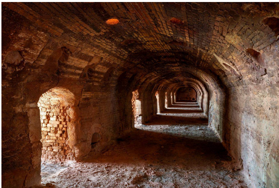
Fig.6. Intérieur de la chambre de cuisson du four Hoffmann
