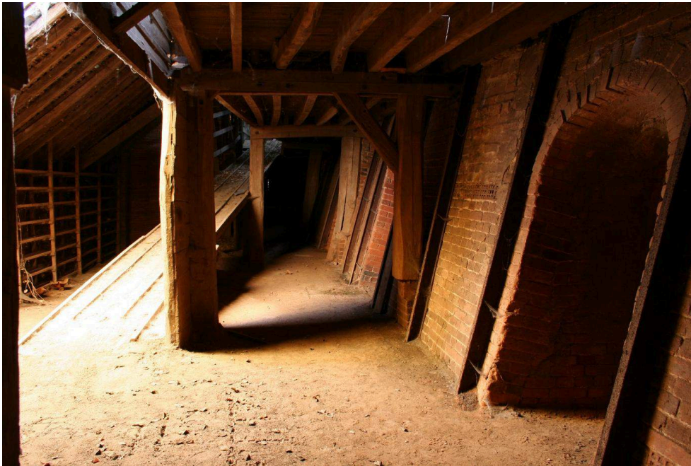
Fig.5. Galerie basse extérieure du four Hoffmann
