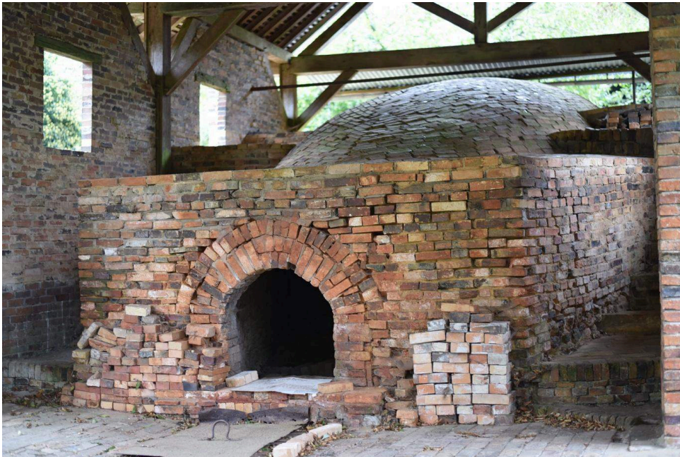
Fig.2. Four Foucher à tirage horizontal du village de La Borne (Cher) en 2023
