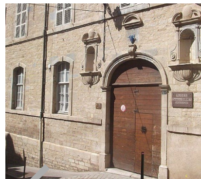
Ancien couvent des Ursulines de Vesoul. Le bureau de l'École des Mines occupait les deux pièces correspondant aux deux fenêtres situées à gauche du porche d'entrée.
