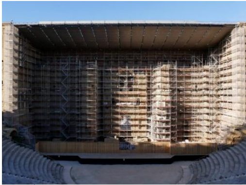
Figure 2 - Échafaudages du front de scène du théâtre d'Orange (S. Borel-Dubourg, IRAA, 2018)
