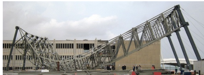
Figure 1.2: Ruine d'une structure par flambage
