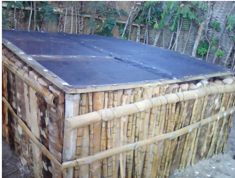
Figure 9c : un bac collectif de 2 m 3 pour le compostage des résidus (crédit photo CEFREPADE)
