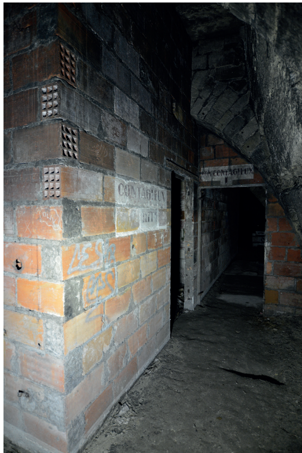
Réaménagements de l'ancienne carrière de calcaire de La Folie (Nanterre)
