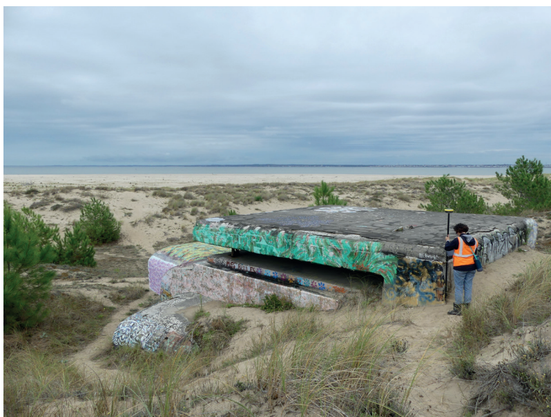
Relevé d'une entité sur le site des Trois-Frères (Le Verdon-sur-Mer). © Q. Baril, 2024
