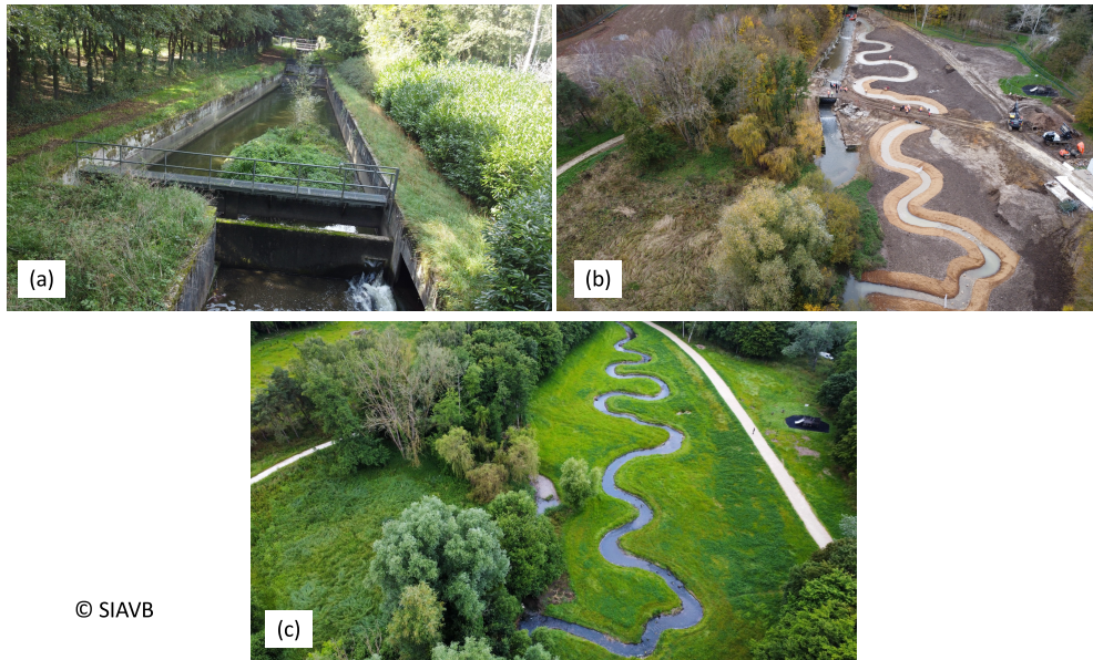
FIGURE 2. Restauration de la section de la rivière Bièvre Bas près à Jouy-en-Josas (Yvelines) : (a) avant travaux, (b) pendant travaux et (c) après travaux.
