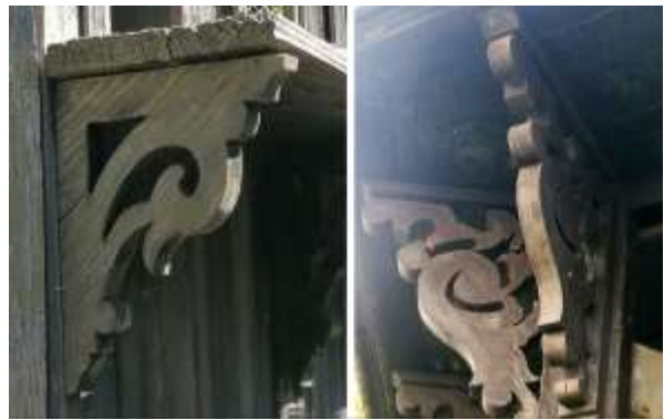
Fig. 48 : Équerres ouvragées
