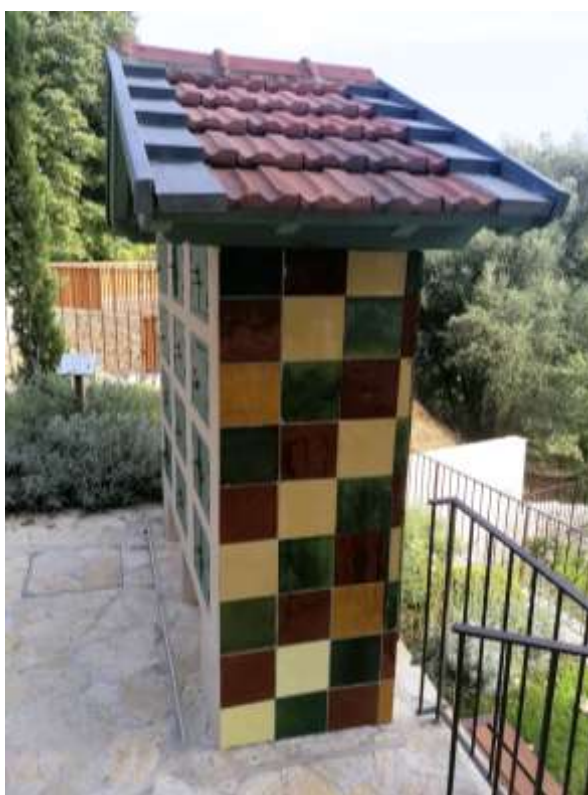
Fig. 56 : Couverture du toit en tuiles plates
