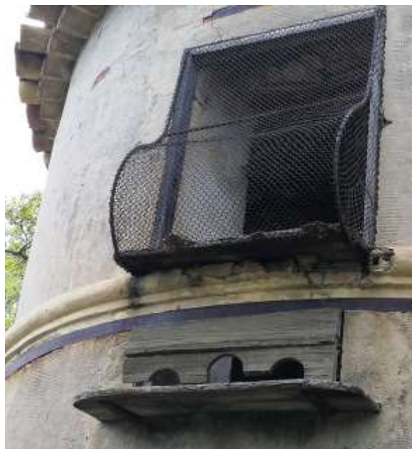
Fig. 30 : Volière grillagée, randière, trous d'envol et de retour
