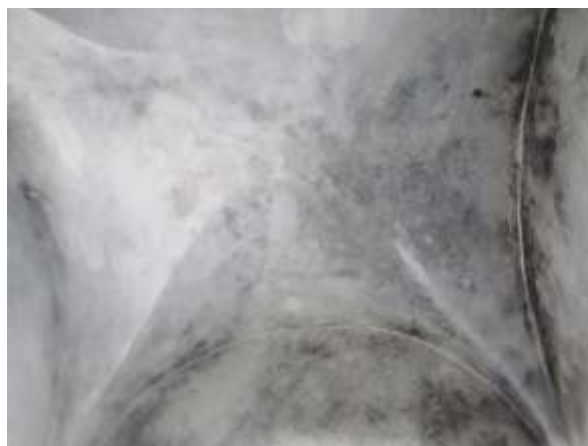
Fig. 89 : Voûte du plafond
