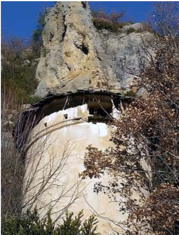
Fig. 23 : Ouvertures en face sud
