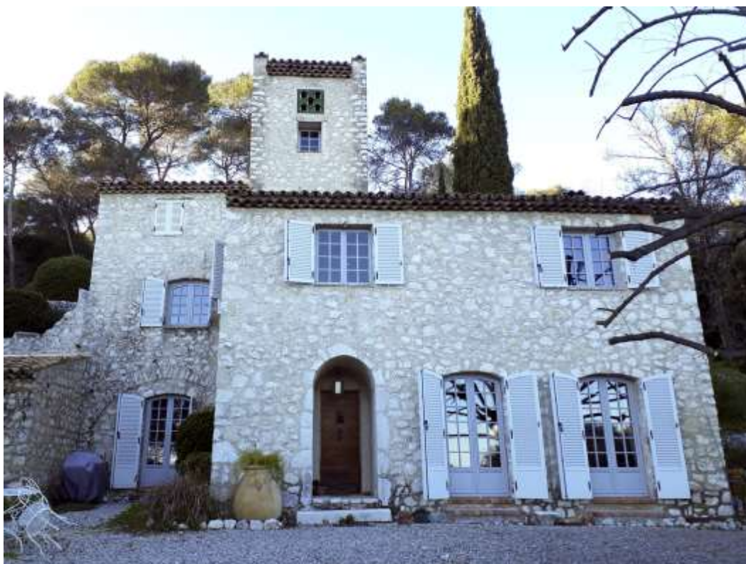
Fig. 87 : Bastide après la restauration
