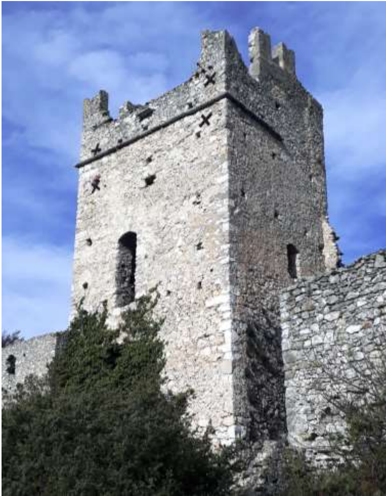
Fig. 83 : Tour pigeonnier crénelée
