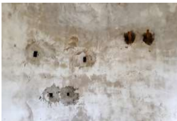
Fig. 32 : Trous pour les tablettes en bois
