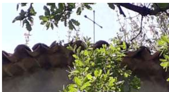
Fig. 31 : Épi de faîtage surmonté d'une croix
