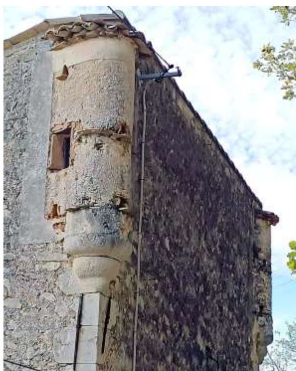
Fig. 91 : Les deux pigeonniers en encorbellement
