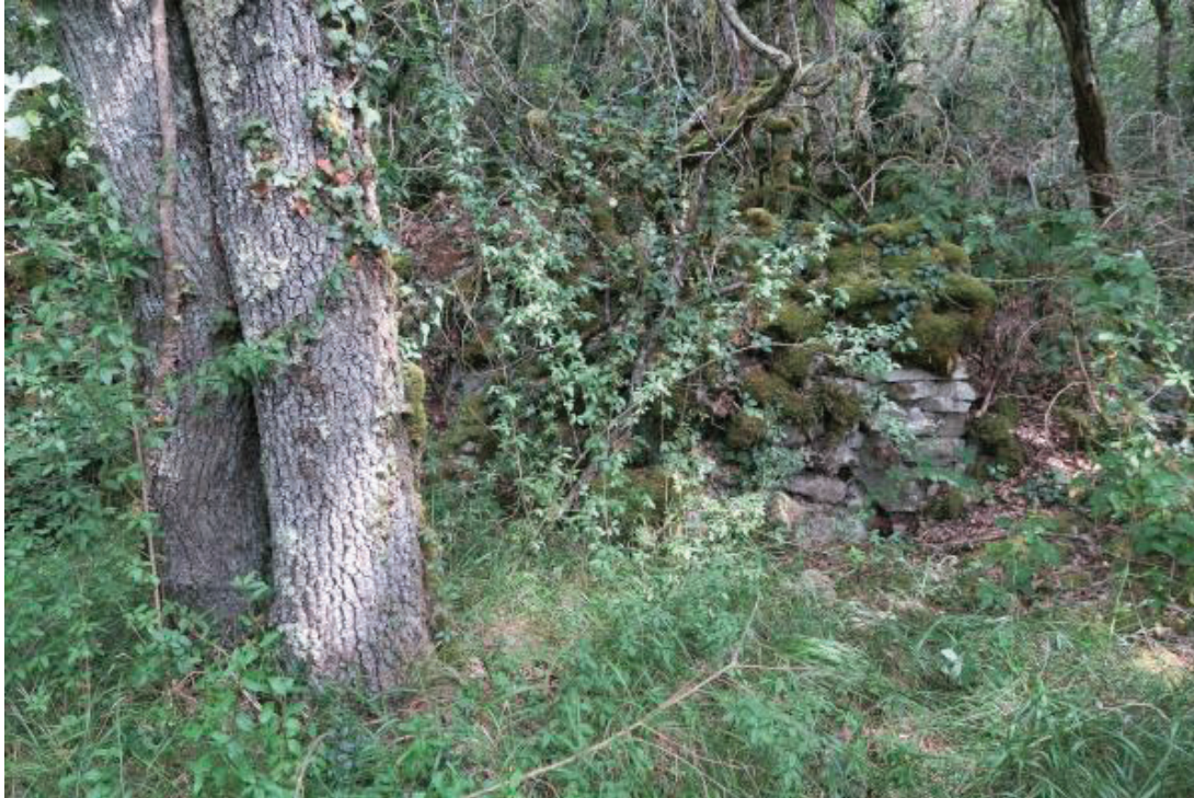
Fig. 27 : Muret construit à l'est de l'entrée de la grotte n° 280
