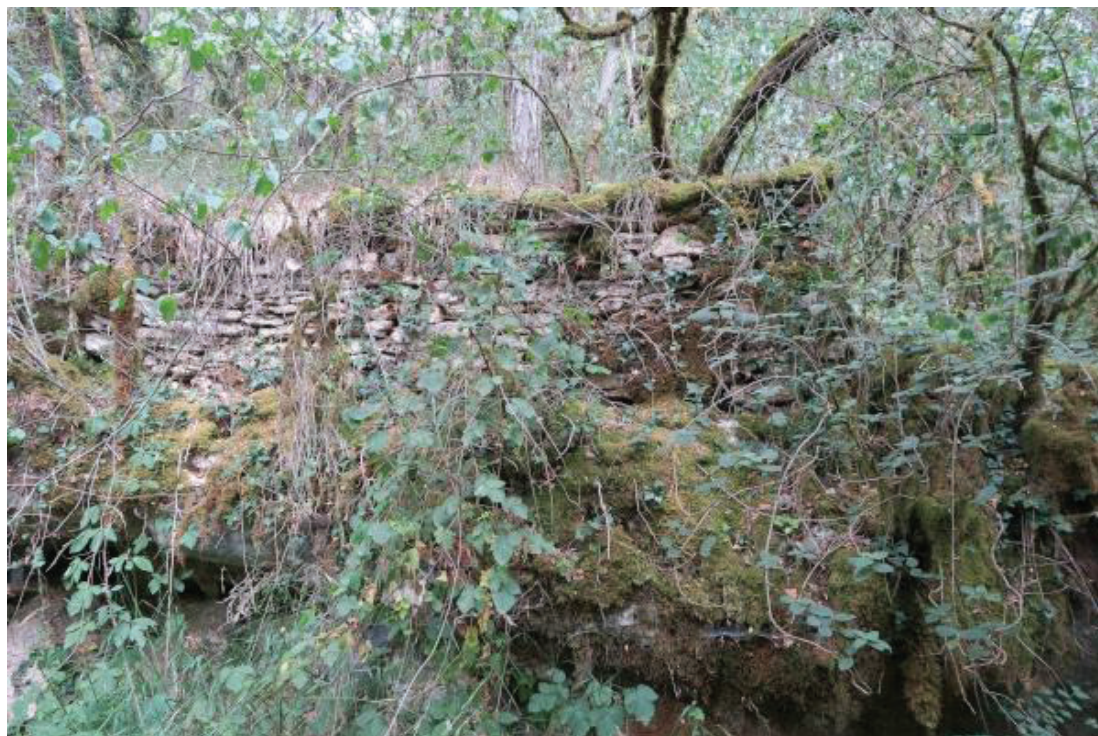
Fig. 36 : Muret surplombant le front rocheux, à l'ouest de l'arche de pierre
