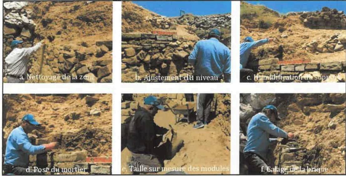
Resim 15: Zarflama yöntemi ile konservasyonun aşamaları (© CRAterre_C. Sadozaï 2022).
