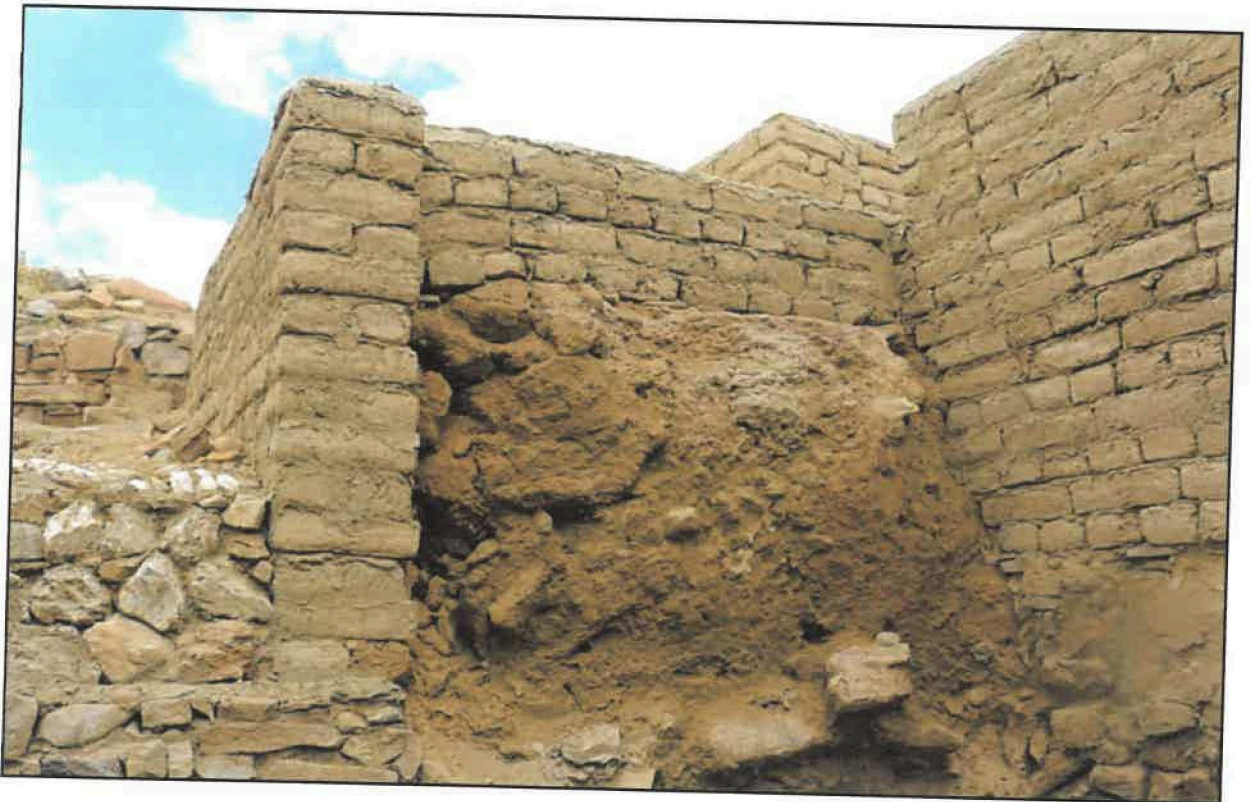
Resim 12: Kuzey kule kalıntıları üzerinde kalıp tekniği uygulaması (©Mission archéologique de Porsuk-Zeyve Höyük)
