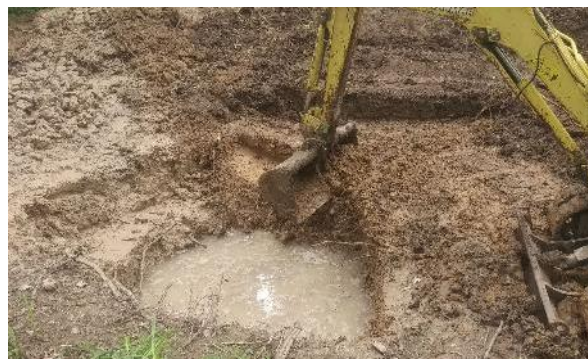
Site pendant travaux – avril 2024
