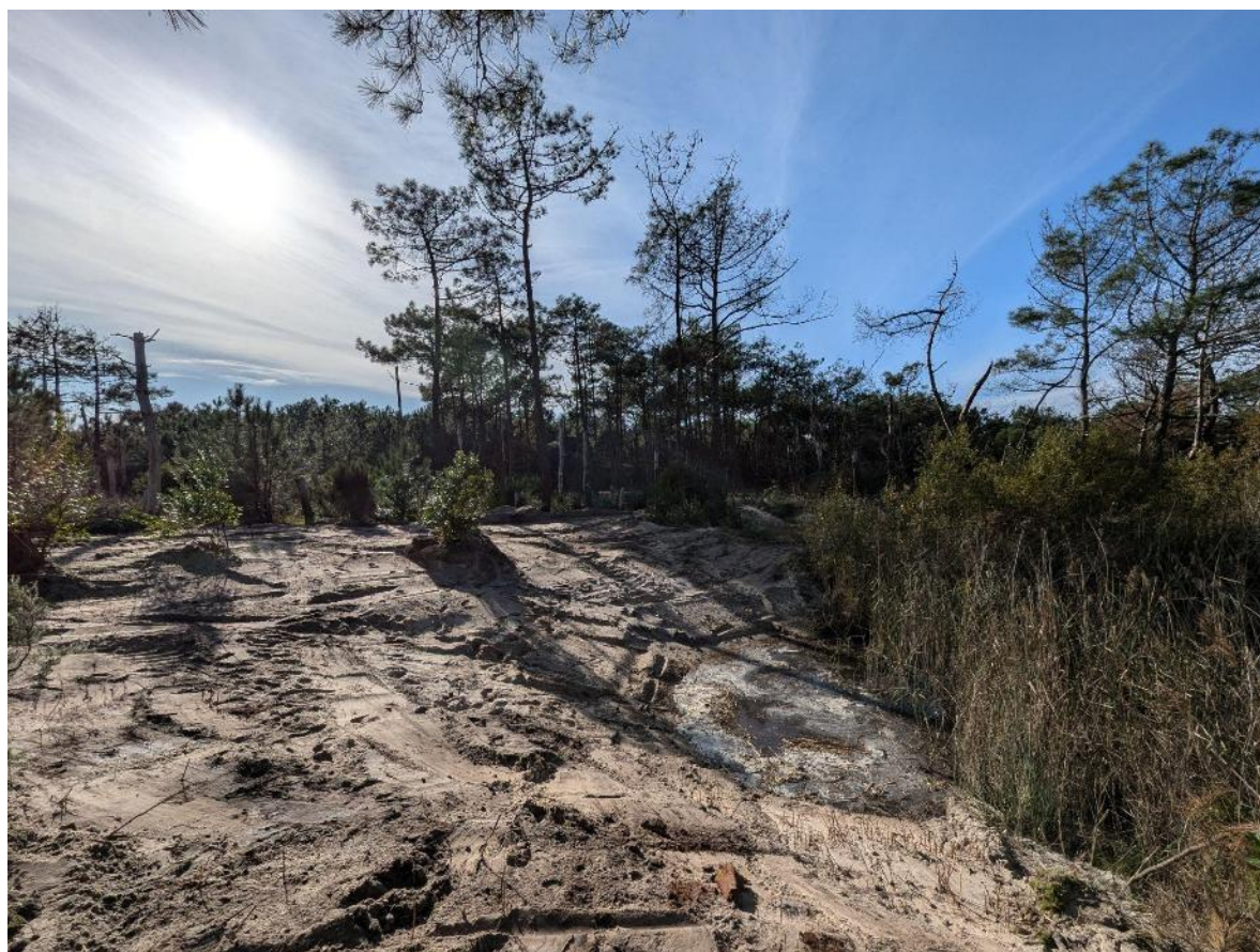
Site après travaux - novembre 2024
