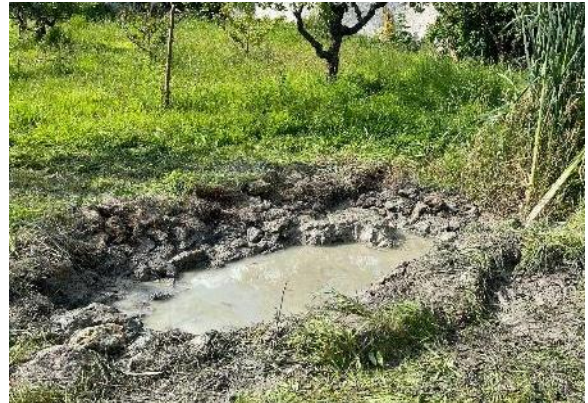
Site en fin de travaux - Juillet 2024
