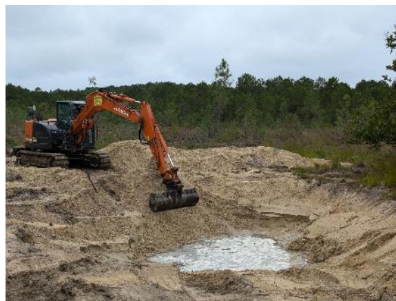
Site pendant travaux - septembre 2024
