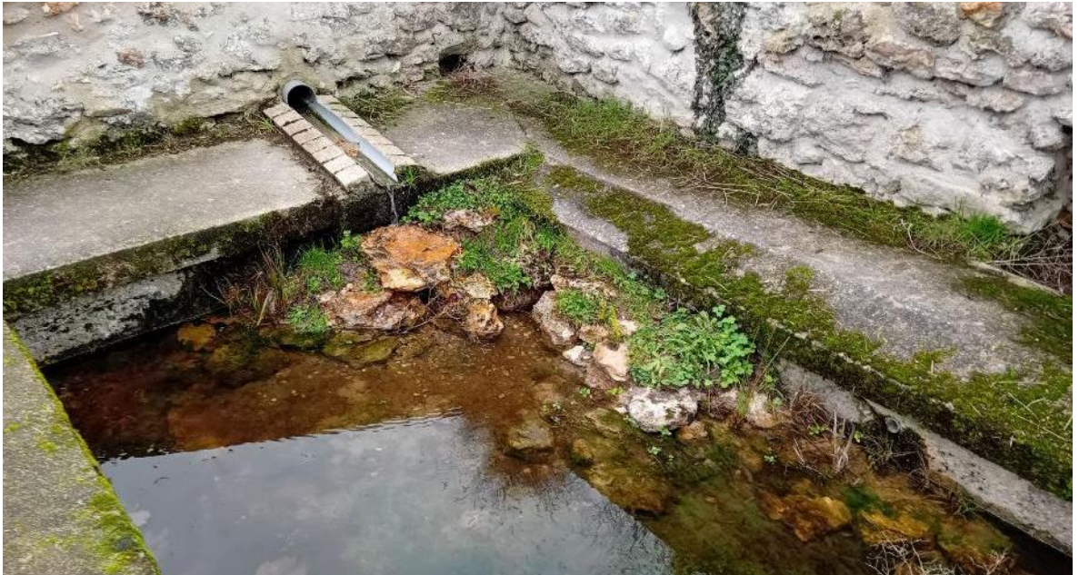
Site après travaux - Novembre 2024
