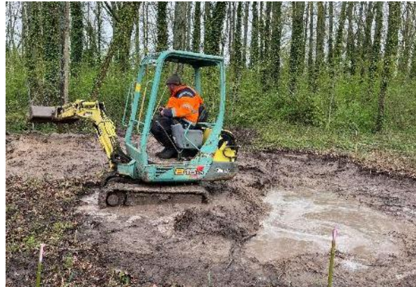
Site pendant travaux – avril 2024
