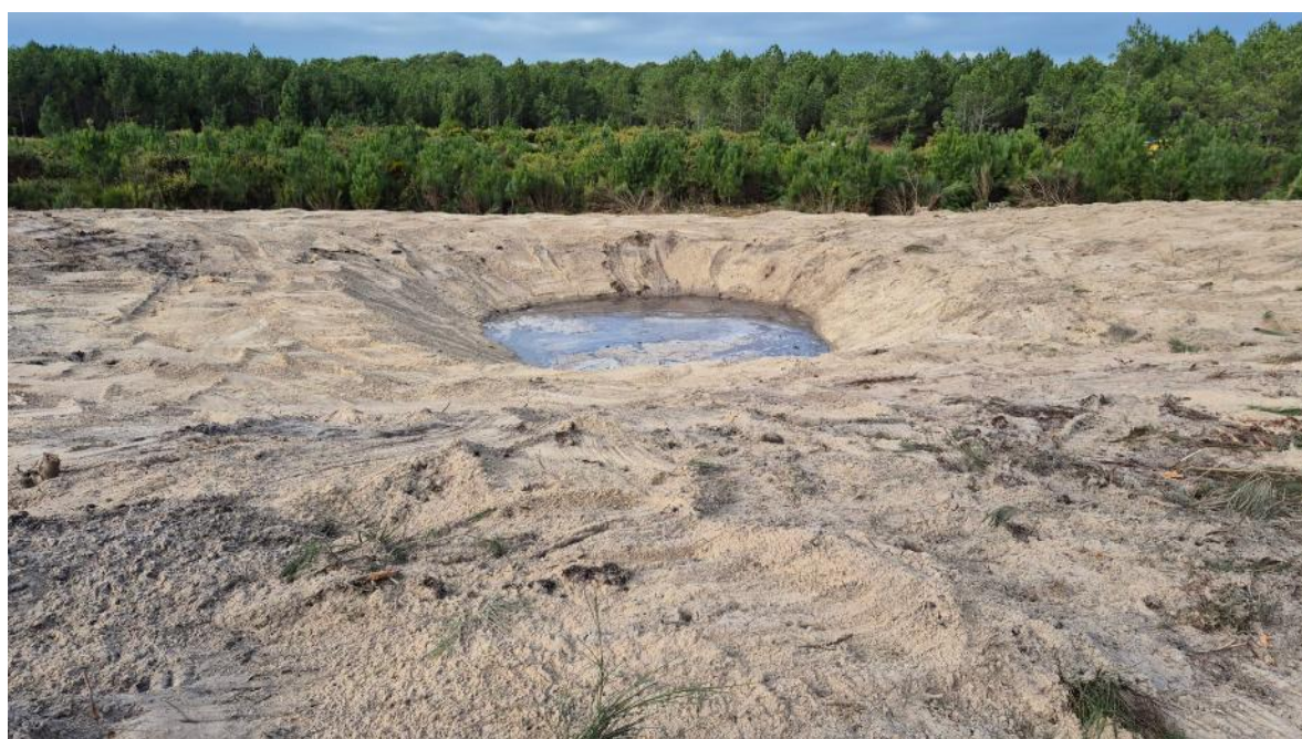
Site après travaux – décembre 2024
