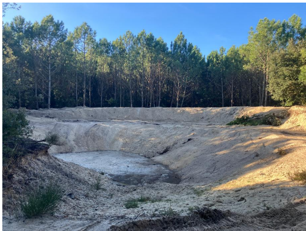
Site après travaux - décembre 2024
