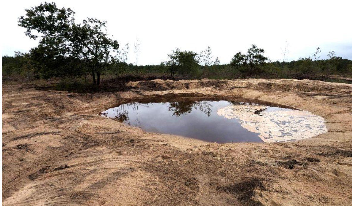
Site après travaux - septembre 2024
