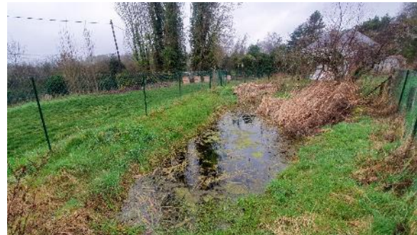
Mare du bas après travaux - Novembre 2023
