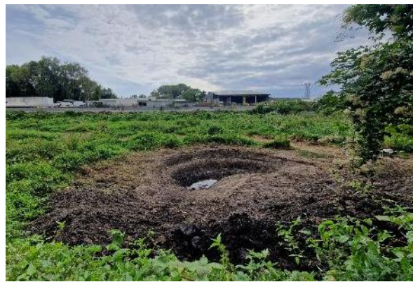
Site pendant travaux - Septembre 2024
