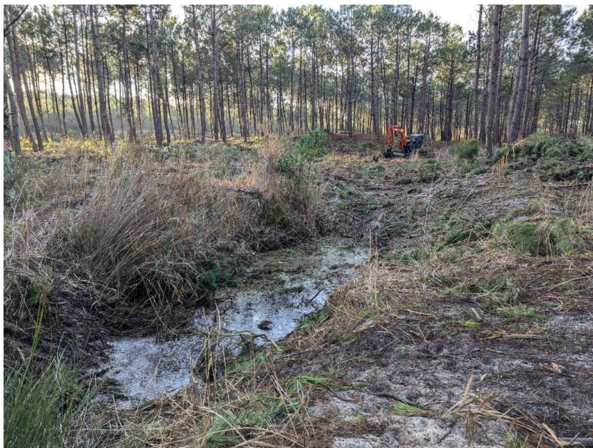
Site après travaux – novembre 2024
