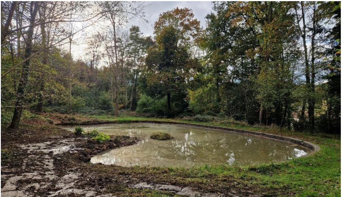
Site après travaux - Novembre 2024
