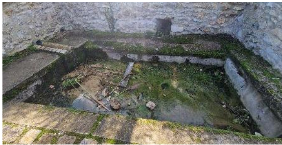
Site avant travaux - Novembre 2024
