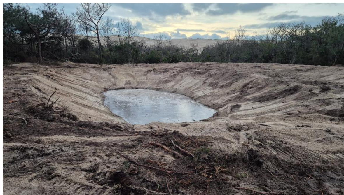
Site après travaux - décembre 2024
