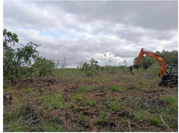
Site pendant travaux - septembre 2024
