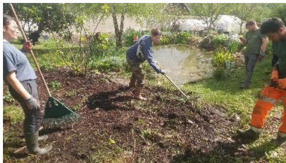
Mare du haut pendant travaux - Juillet 2024
