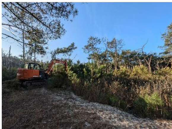
Site avant travaux - novembre 2024
