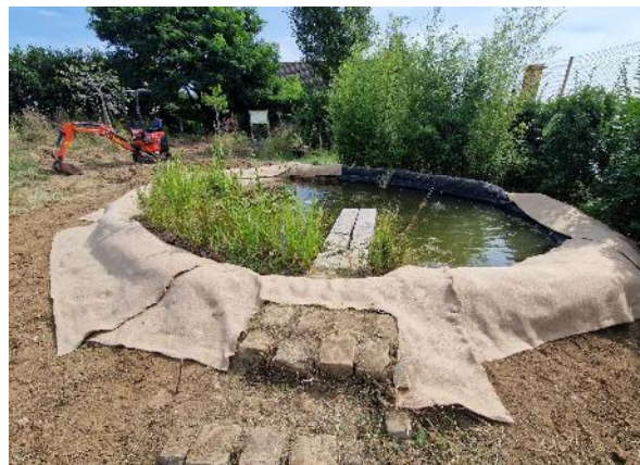
Site pendant travaux - Août 2024
