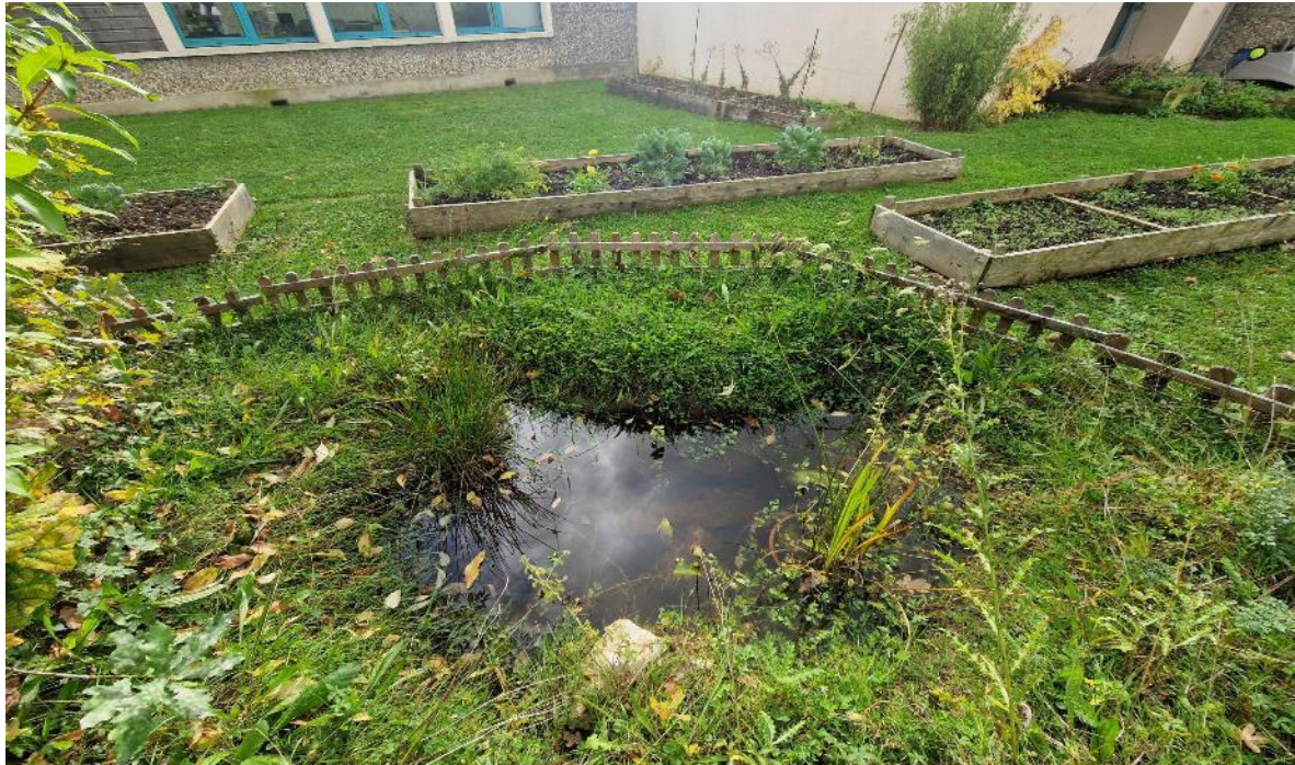
Site après travaux - Août 2024
