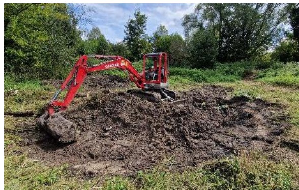
Site pendant travaux - Septembre 2024
