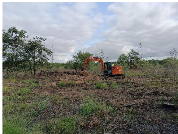
Site pendant travaux - septembre 2024
