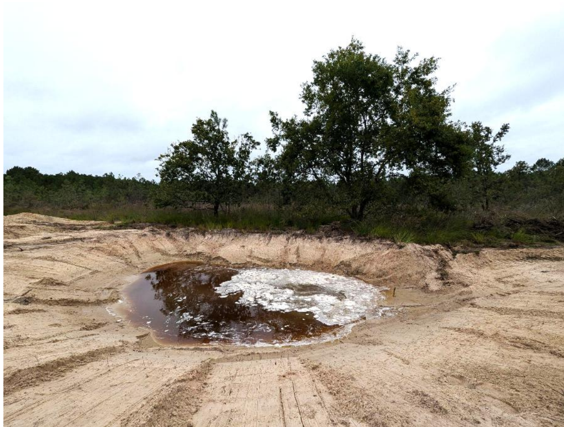
Site après travaux - septembre 2024
