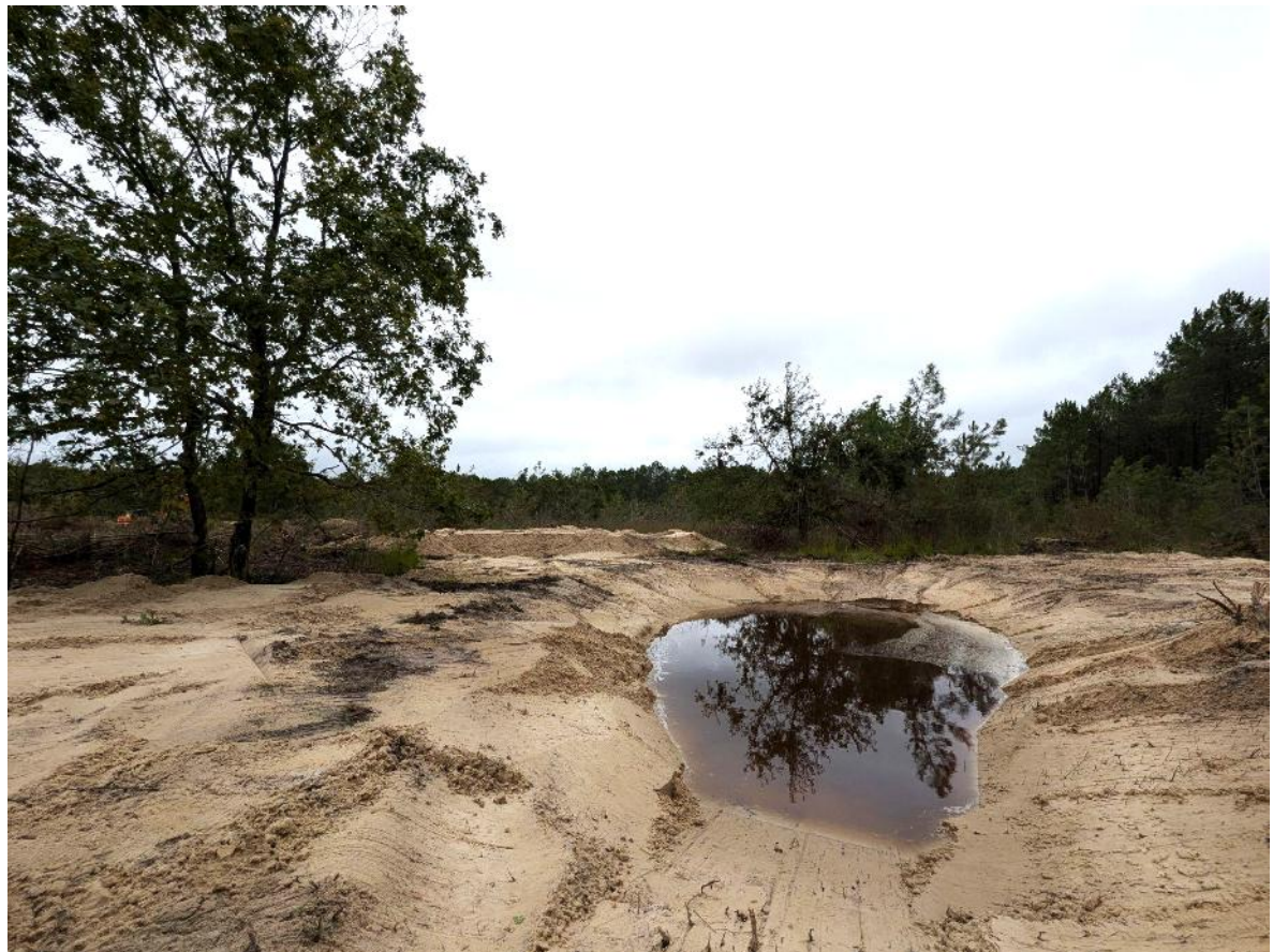
Site après travaux - septembre 2024
