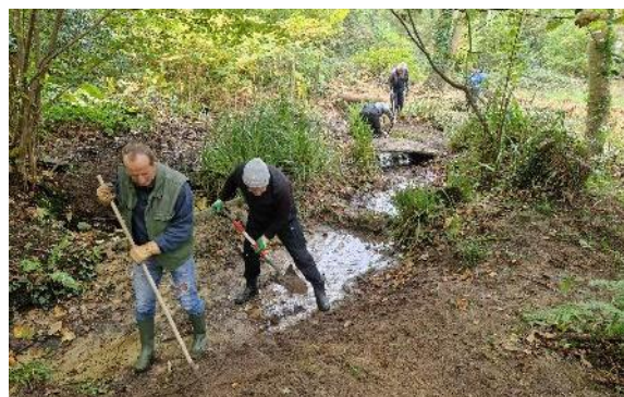
Site pendant travaux - Novembre 2024
