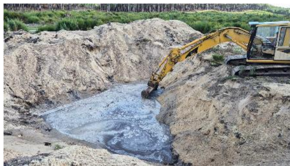
Site pendant travaux - décembre 2024
