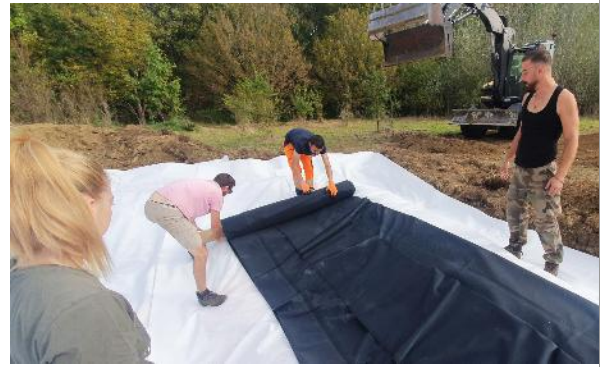
Site pendant travaux - Octobre 2023
