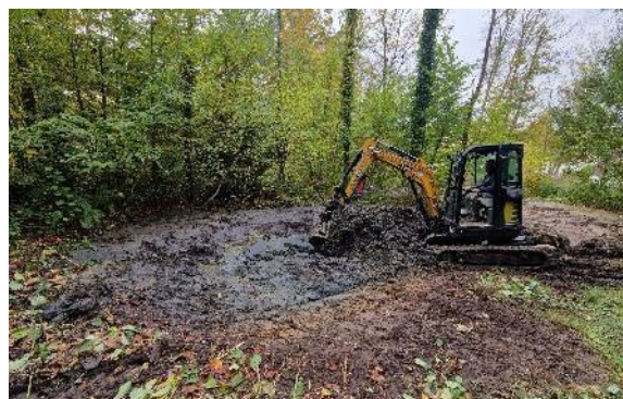
Site pendant travaux - Novembre 2024
