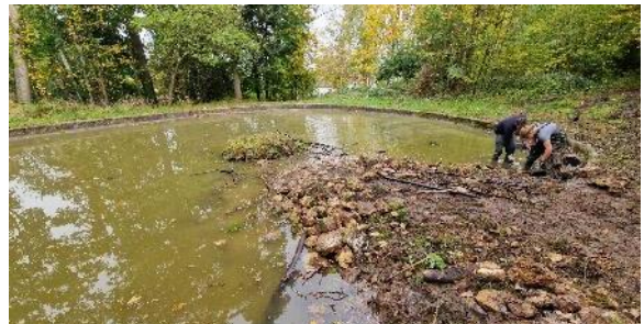
Site pendant travaux - Novembre 2024
