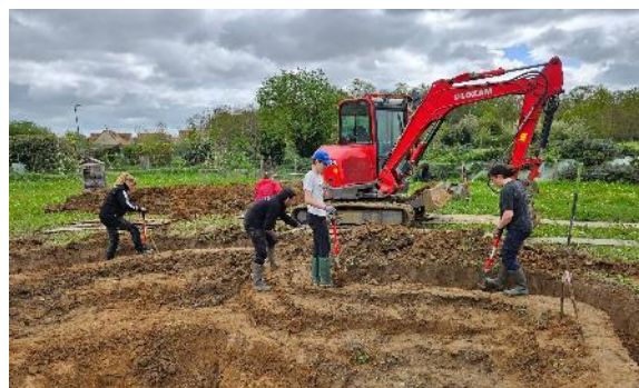
Site pendant travaux - Avril 2024
