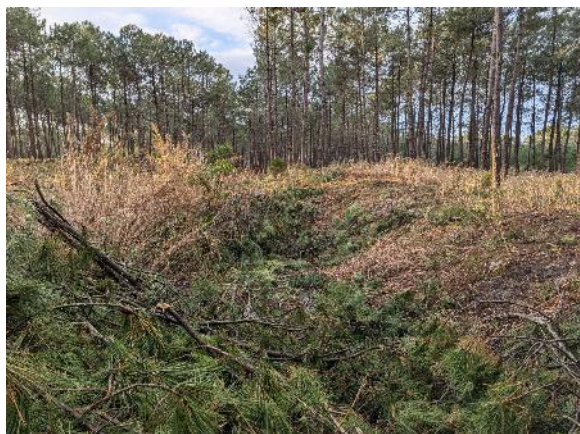
Site avant travaux – novembre 2024
