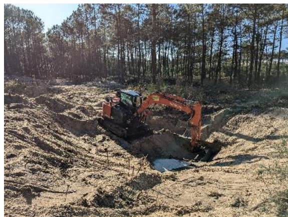
Site pendant travaux - novembre 2024
