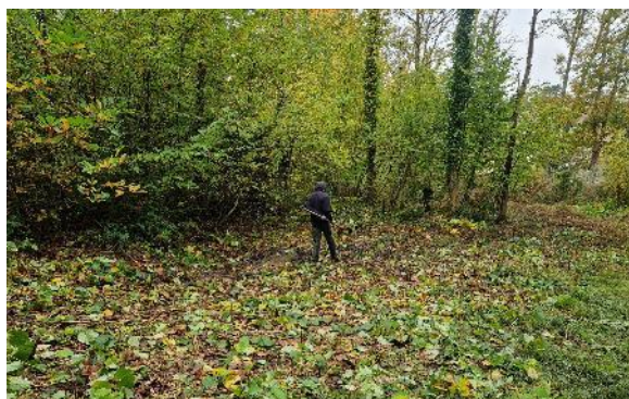
Site avant travaux - Novembre 2024
