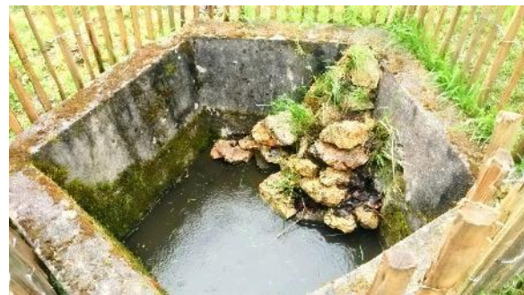
Puit central après travaux - Avril 2024
