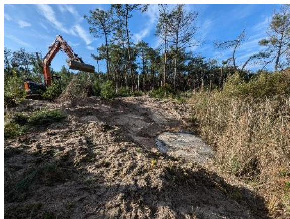
Site pendant travaux - novembre 2024
