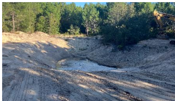
Site pendant travaux - décembre 2024
