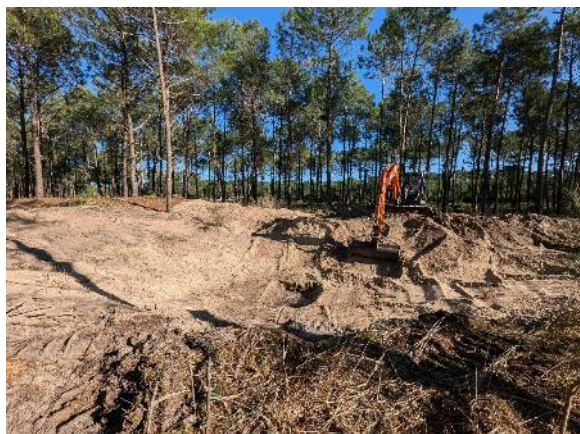
Site avant travaux - novembre 2024
