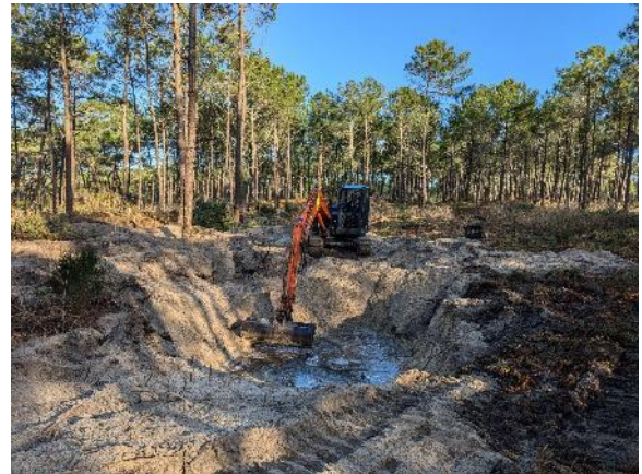
Site pendant travaux - novembre 2024
