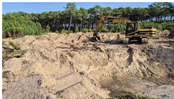
Site pendant travaux – décembre 2024
