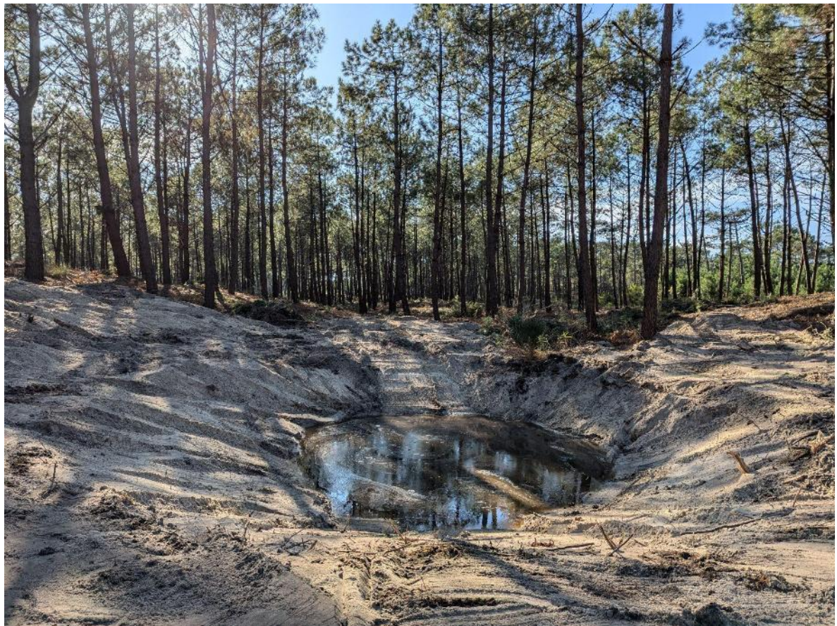
Site après travaux - novembre 2024
