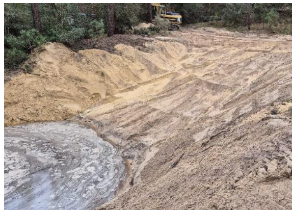
Site pendant travaux - décembre 2024
