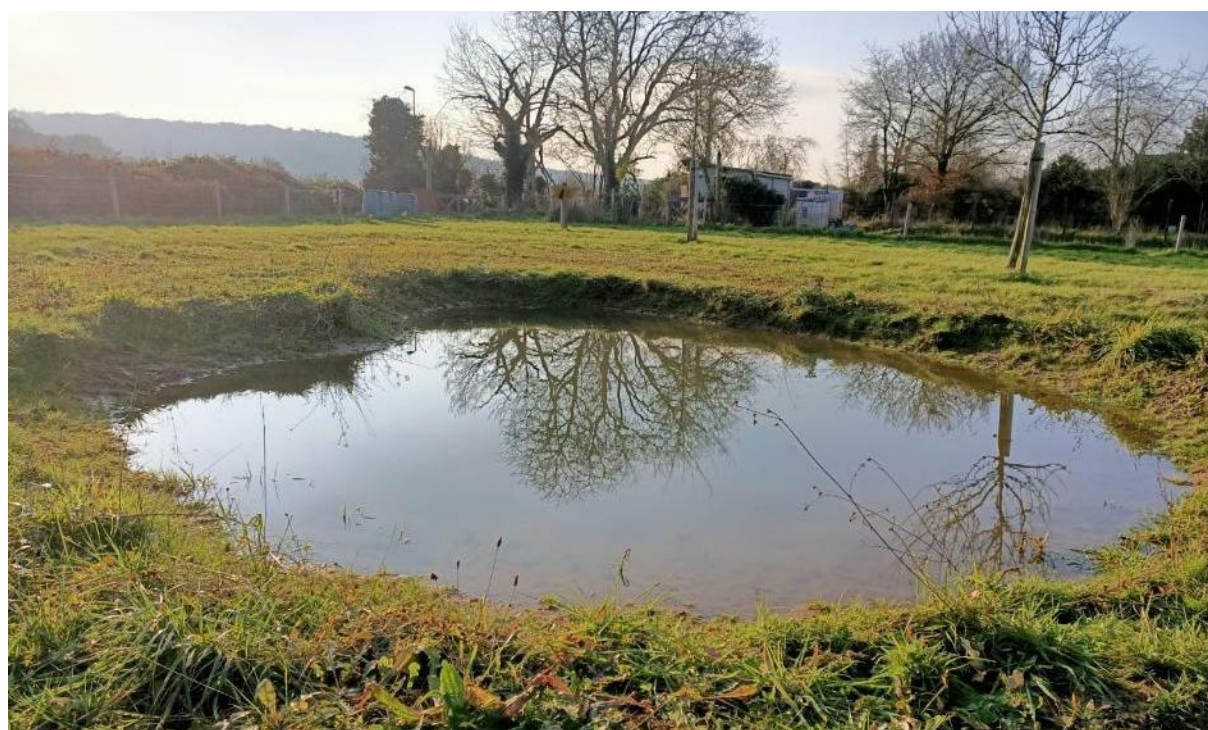
Site après travaux - Janvier 2025 (photo Sabine Carlach)
