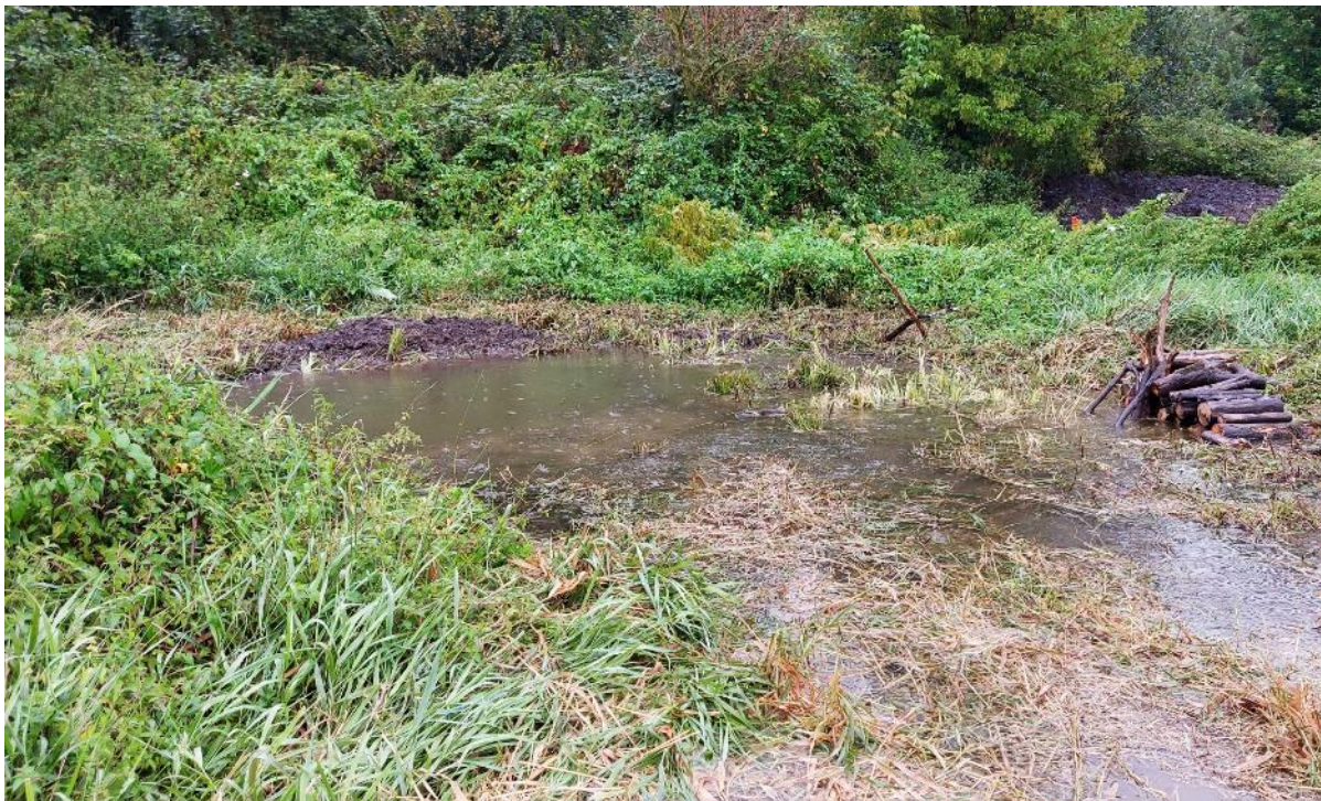
Site après travaux - Septembre 2024
