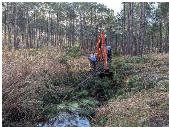
Site pendant travaux – novembre 2024
