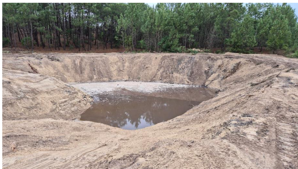
Site après travaux - décembre 2024
