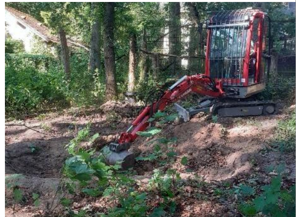
Site pendant travaux - Juillet 2023
