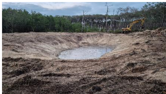
Site pendant travaux - décembre 2024
