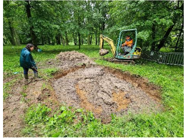
Site pendant travaux - Avril 2024
