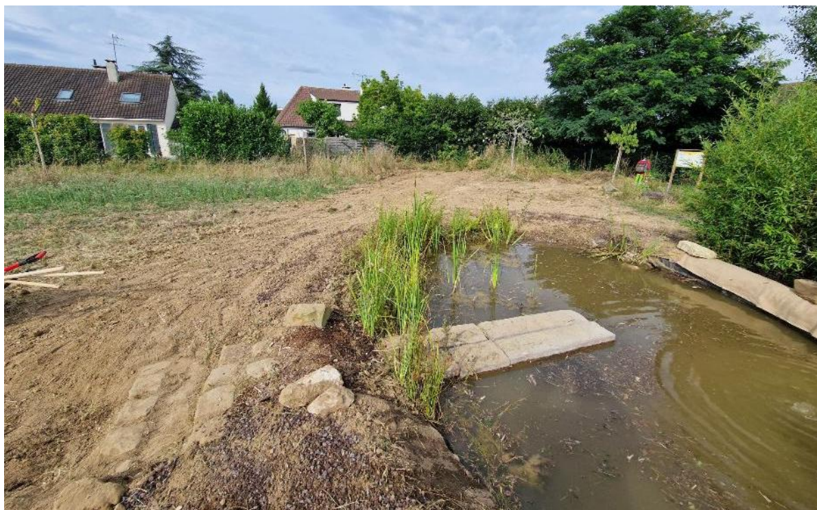
Site après travaux - Août 2024
