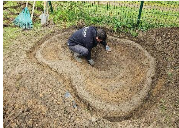
Site pendant travaux - avril 2024
