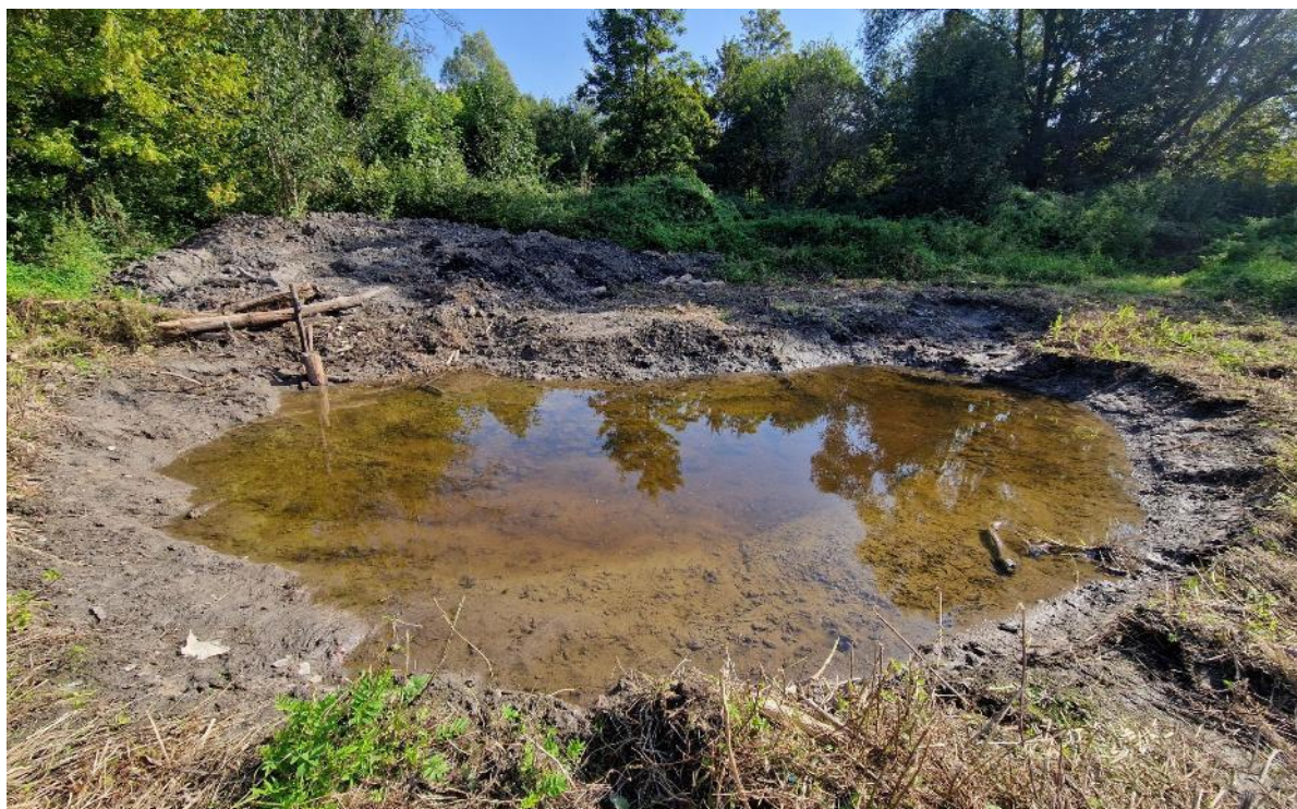
Site après travaux - Septembre 2024
