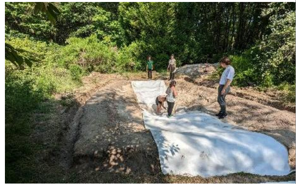
Site pendant travaux - Juin 2023
