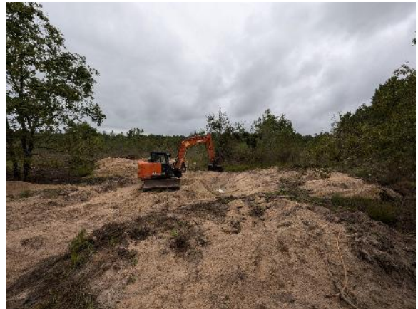
Site pendant travaux - septembre 2024
