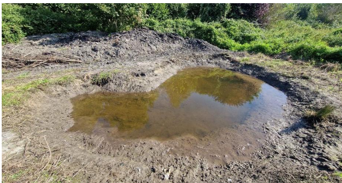
Site après travaux - Septembre 2024
