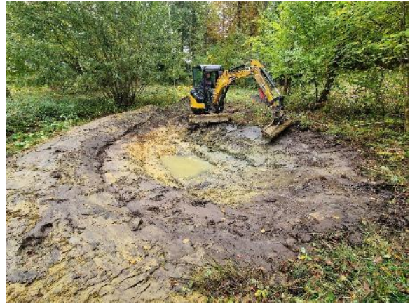
Site pendant travaux - Novembre 2024
