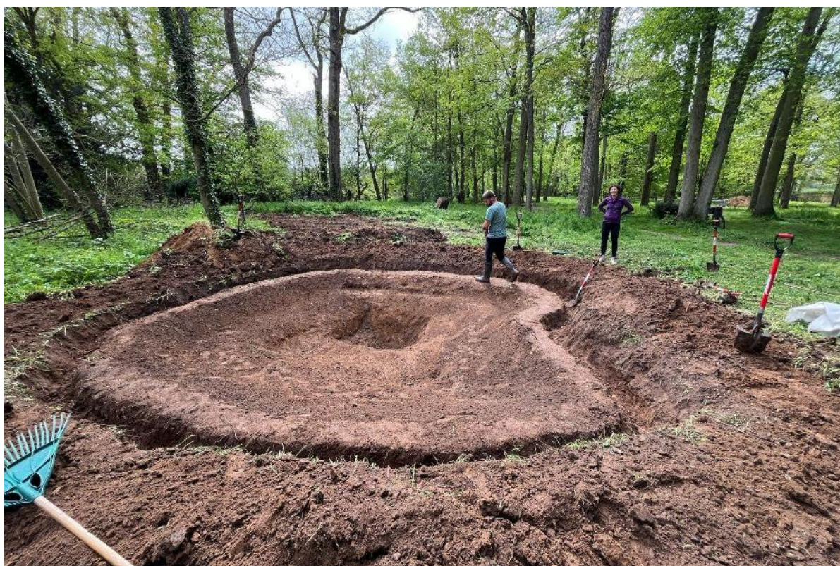
Site pendant travaux - Avril 2024
