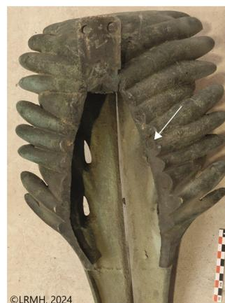
Figure 31. Chiffre 6 incisé sur le revers d'une palmette démontée d'un chapiteau ©LRMH, 2024
