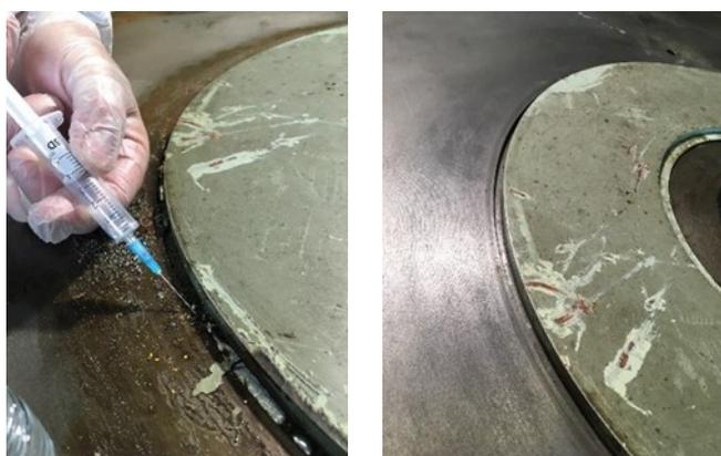
Figure 8. Aspiration des gouttes de mercure à la seringue. Avant (à gauche) et après (à droite)
