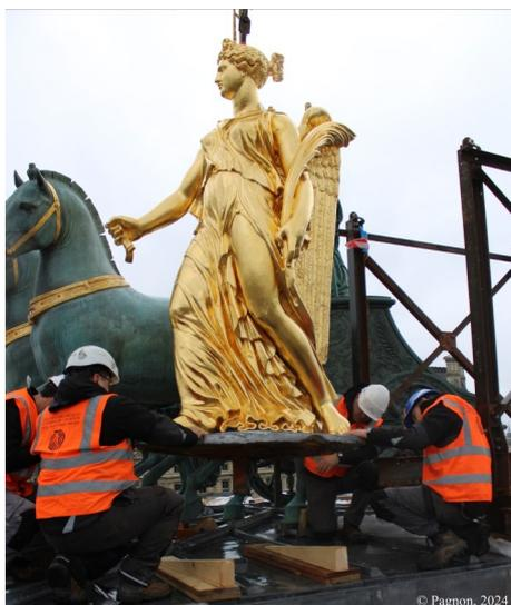
Figure 25. Système de calage provisoire en bois permettant de compenser la pente de la terrasse, sculpture de la Victoire
