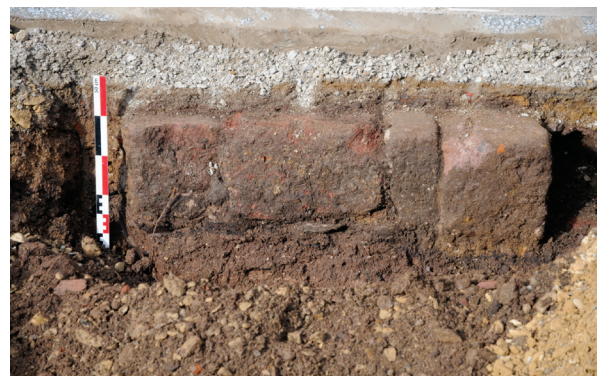
9 > Détail de la structure maçonnée US 3003 (cl. : Ph. Gruat).
