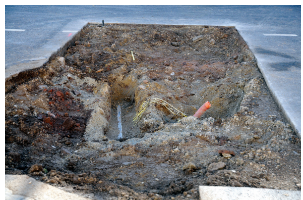
10 > Vue du sondage 10 depuis l'ouest qui a dû être interrompu en raison de la présence du réseau de gaz (cl. : Ph. Gruat).
