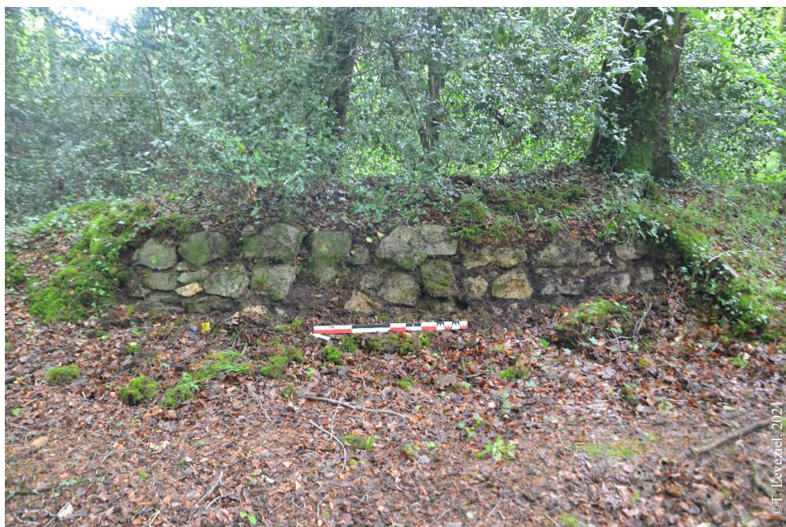
Fig. 35 : Vue de profil de la structure MR1, mur maçonné situé sur la partie sud de la plateforme.
