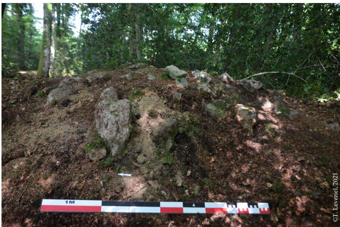
Fig. 34 : Vue de profil de la tête du talus interne maçonné et du mortier désagrégé, en place.
