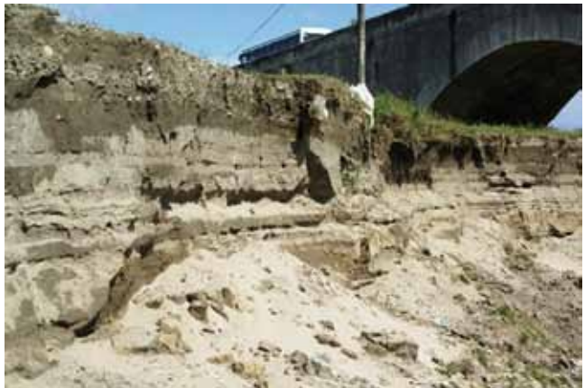
Photo 1 – Dépôt de sédiments formant la marge alluviale. Ces sédiments sont remobilisés progressivement au rythme des crues. © CNR
