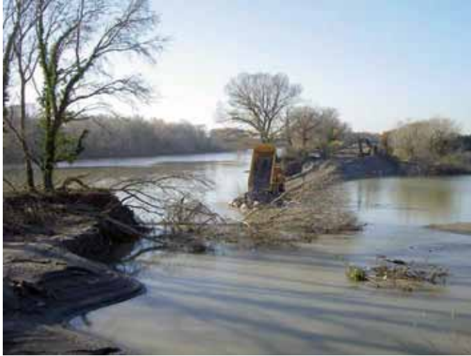
Photo 2 – La brèche de Petite Argence. ©SYMADREM
