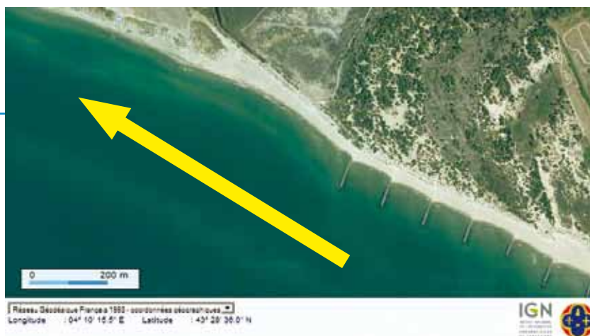
Photo 1 – En Petite Camargue, la batterie d'épis induit une érosion importante à l'ouest, liée à la dérive littorale est-ouest sur ce secteur. © FDP IGN site http://www.geoportail.fr
