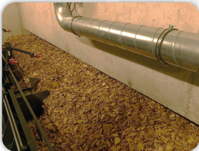
Plaquettes de bois de la chaudière collective de la CC de Bitche (© CC de Bitche).
