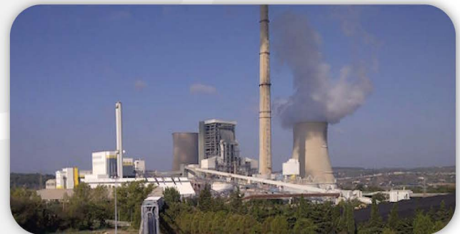
Les deux tranches de la centrale de Provence Tranche 4 au bois à gauche et tranche 5 au charbon à droite. Source : Uniper
