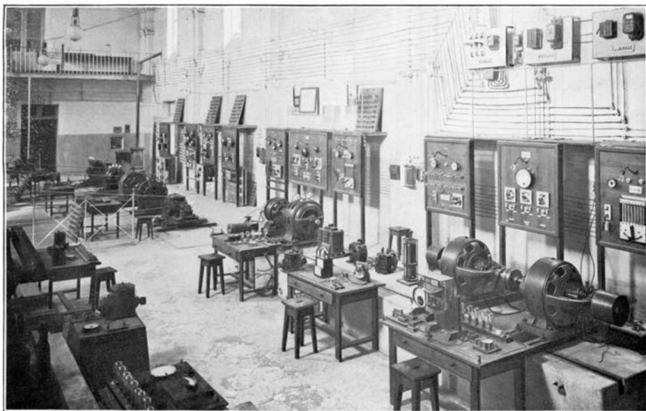
**Figure 4.7** Salle des machines électriques des 2<sup>e</sup> et 3<sup>e</sup> années, côté réceptrices : moteurs à courant continu et à courant alternatif (asynchrones).
