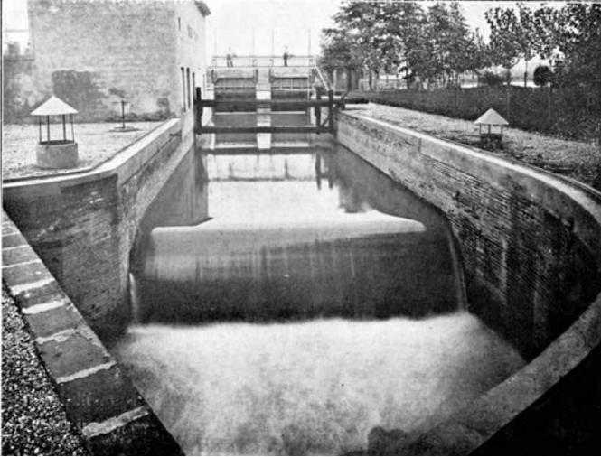
**Figure 5.7** Partie amont du canal courbe du laboratoire de Banlève et son déversoir étalon de Bazin. On voit, de part et d'autre du déversoir, les événements prévenant toute dépression sous la lame d'eau déversante.
