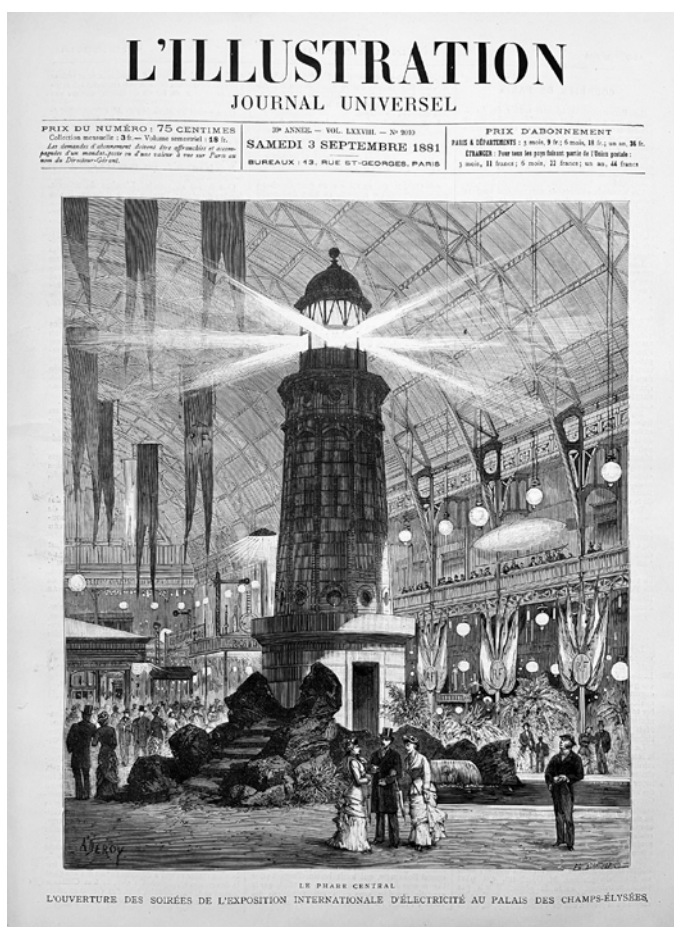
Figure 1.1 Le phare de l'Exposition internationale de l'électricité de 1881 ; sa lampe à arc est alimentée par une génératrice Gramme ( L'illustration n° 2010, 3 sept. 1881).
