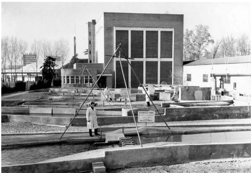
Figure 8.7 Le « laboratoire plat » des maquettes d'hydraulique dans les années 1950 ; au fond, le bâtiment de la soufflerie ; à droite, la couverture du canal rectiligne.
