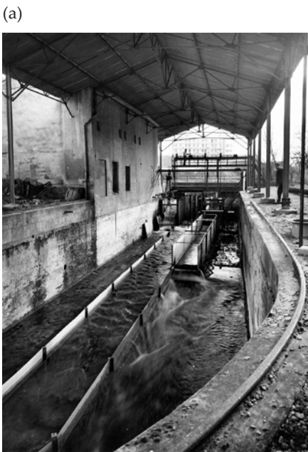
Figure 5.9 Canal courbe investi de modèles réduits d'ouvrages hydrauliques : (a) partie amont couverte vers 1930 ; (b) partie aval avec, à l'arrière-plan, le pont sur la chaussée de Banlève.
