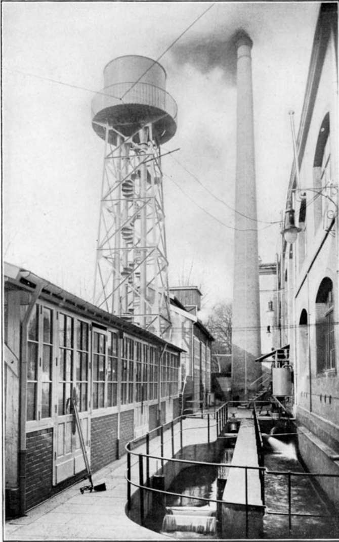
Figure 5.2 Cour du laboratoire d'hydraulique : pylône et réservoir supérieur de 20 \text{ m}^3 , chaufferie, tour réfrigérante (au fond), cheminée, bache avec ajutages en mince paroi, dispositif pour les essais d'ajutages, déversoir et bassin inférieur de 80 \text{ m}^3 .
