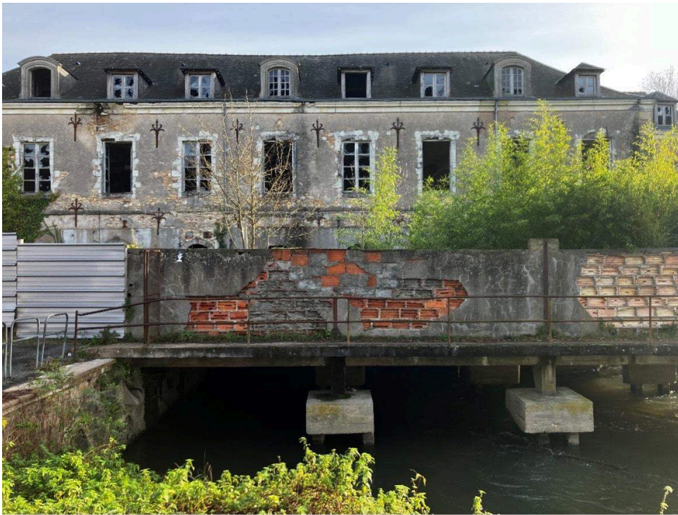
Figure 13. La papeterie de Gouis en rive droite du Loir, Durtal
