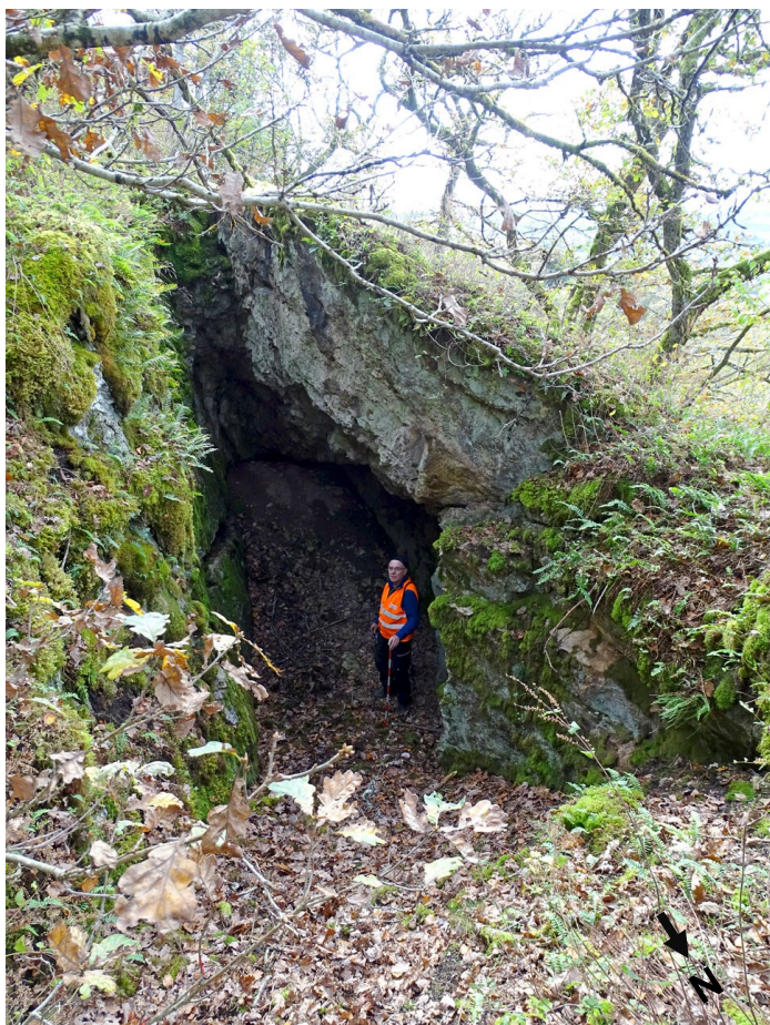
Le défilage au jour vu depuis la crête en direction du sud. Le filon a été entièrement vidé. La partie terminale de la mine, paroi ouest, est recouverte par un surplomb rocheux
