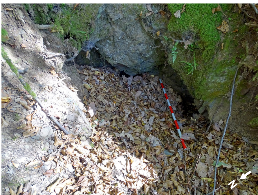
La partie comblée par des roches s'est affaissée et laisse voir le remplissage de la galerie.
