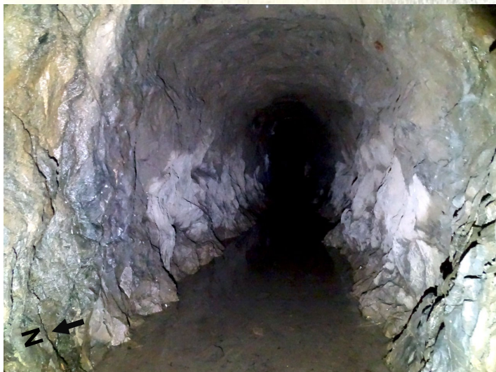
Photo de la galerie inondée.
