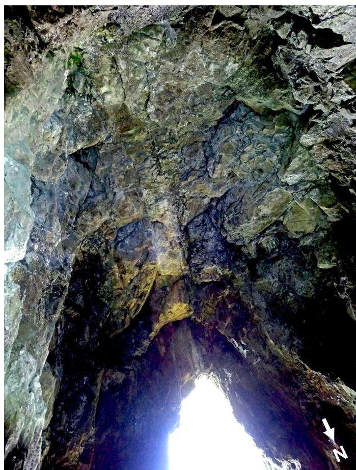
Le filon exploité dans cette mine mesure une vingtaine de centimètres de largeur. Il est incliné de 20° vers l'ouest et se dirige vers le nord/nord-est.
