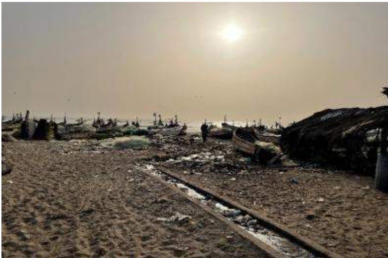
Photographie 3. Canal d'évacuation des eaux usées à ciel ouvert au Cap Skirring
