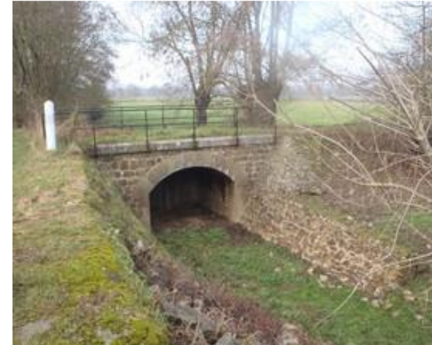
Exutoire du ruisseau de l'île
