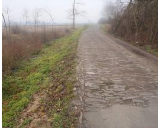
Déversoirs à radiers
