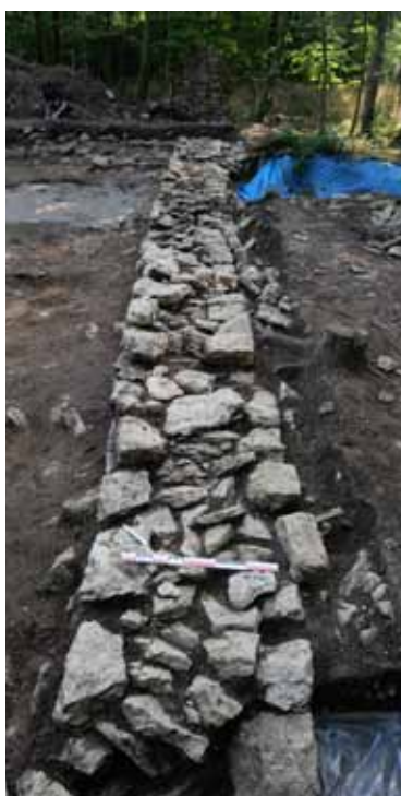
Fig. 17 Mur 126. On constate que le mur n'est pas tout à fait droit
