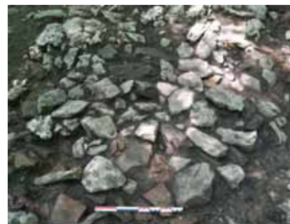
Fig. 86 Partie sud du niveau de démolition 102 où était concentré les blocs de grès
