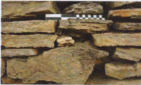
FIG. 2.9. Petites dalles de rhyolite locale utilisées pour la construction des murs.
