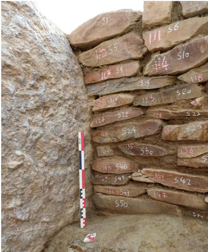
**Fig. 60 – Vue de la jonction entre le parement sud et la dalle de poudingue F52, formant la paroi est. Les moellons sont parfaitement ajustés contre la dalle (cliché C. Nicolas).**
