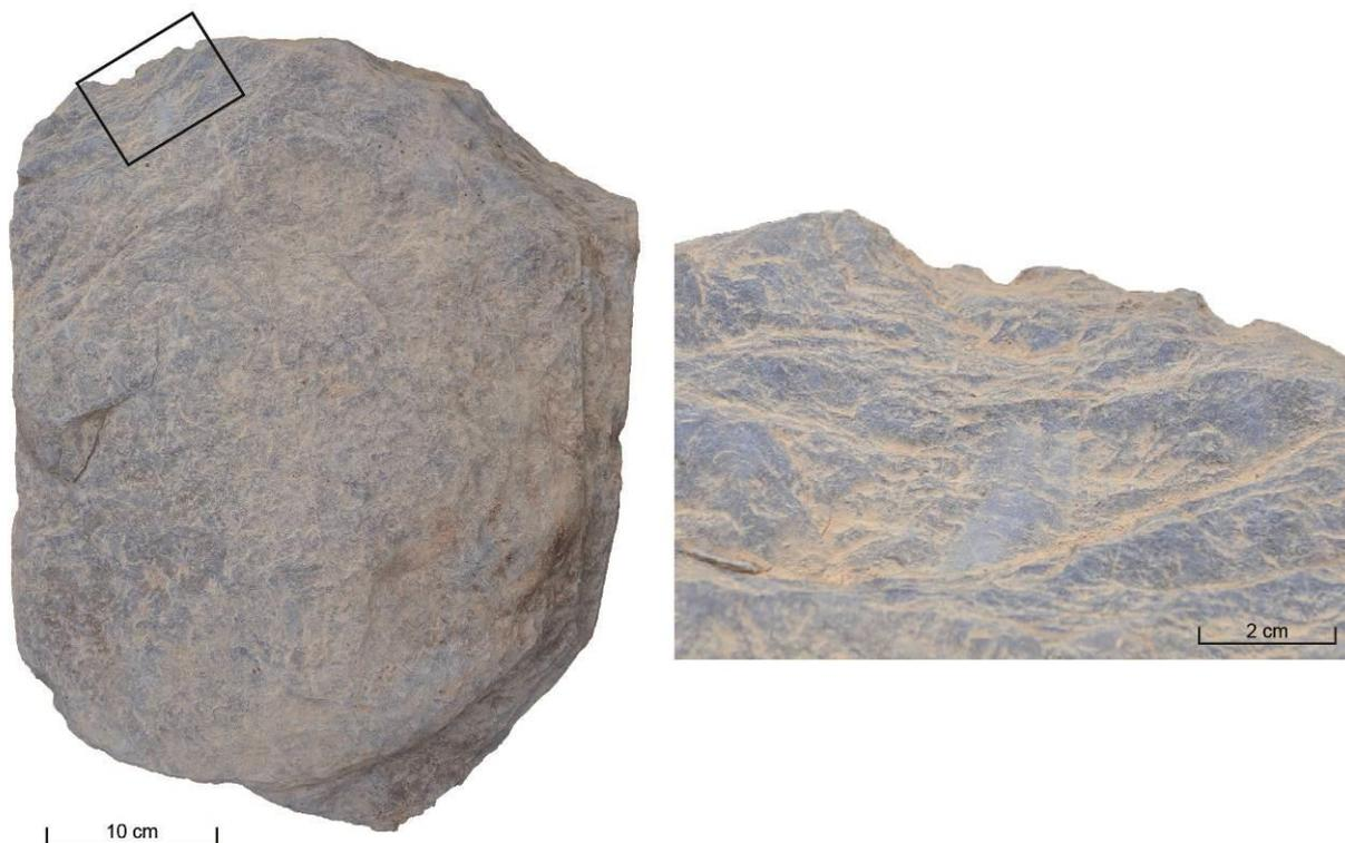
**Fig. 103 – Dalle de schiste présentant des traces de broches de carrier (c. 5 mm de largeur), garni du mur nord (clichés C. Nicolas).**
