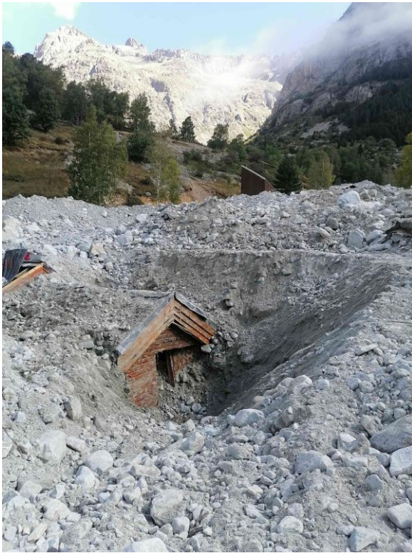
Figure 2: Gauche : bâtiment complètement engravé par la crue, partiellement mis à jour (photo du 17 septembre 2024). Droite : chapelle et bâtiments partiellement détruits par les incisions du torrent des Etançons deux jours après l'évènement, le 23 juin 2024.
