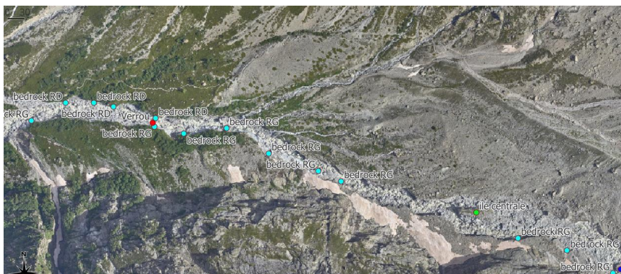
Figure 81: Photographie aérienne post-crue et présence de substratum rocheux sur le linéaire entre le sommet du cône et le glacier.
