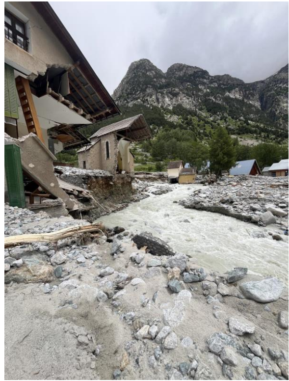
Figure 2: Gauche : bâtiment complètement engravé par la crue, partiellement mis à jour (photo du 17 septembre 2024). Droite : chapelle et bâtiments partiellement détruits par les incisions du torrent des Etançons deux jours après l'évènement, le 23 juin 2024.
