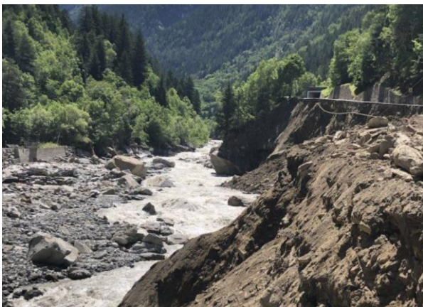
Figure 3: A gauche : érosion de berge sur le torrent de Grand Eyvia dans le Val de Cognes. A droite : débordements torrentiels dans le centre-ville de Breuil Cervinia (source : analisi dell'evento alluvionale del 29-30 giugno 2024 – protection civile centro funzionale regione autonoma valle d'Aosta).
