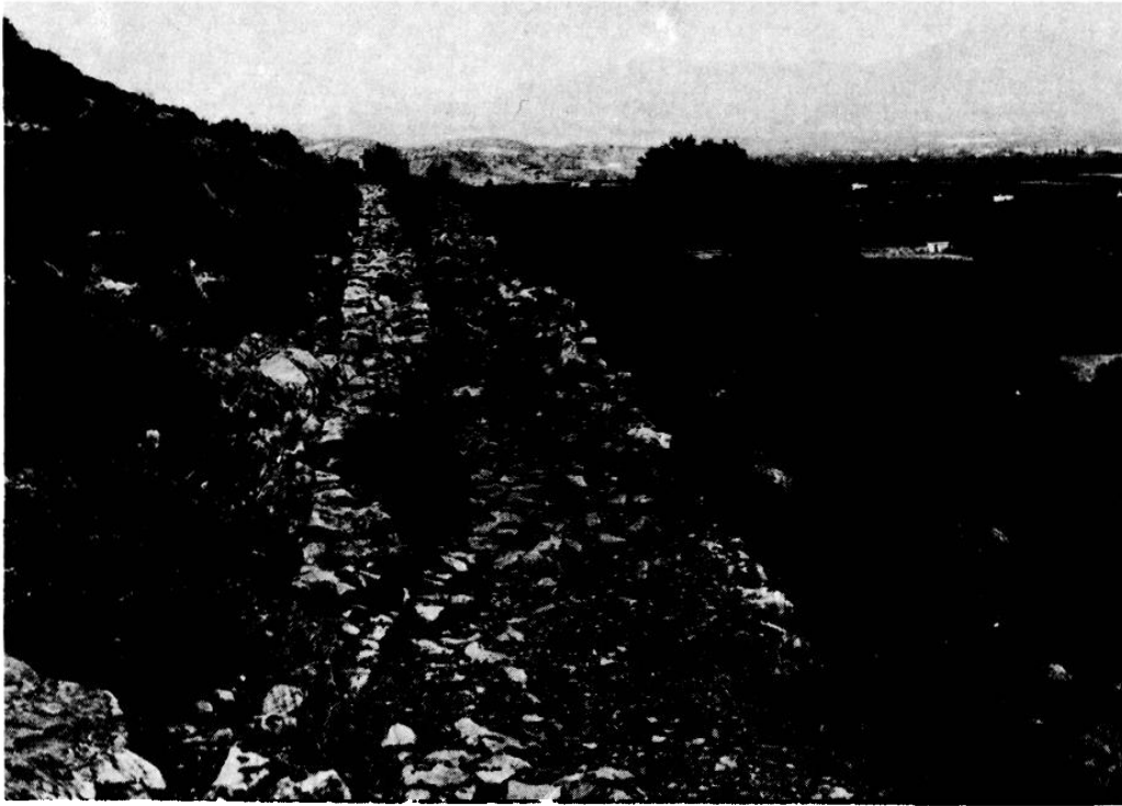
Fig. 34. — L'aqueduc Nord sur le flanc Est de la hauteur de Tsoukka.
