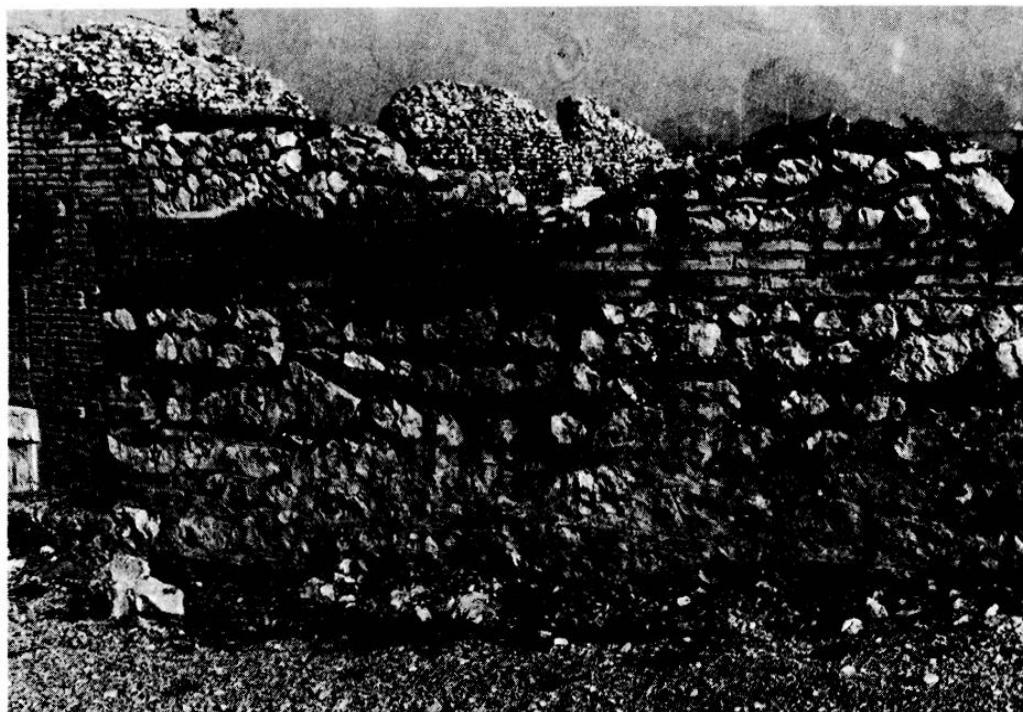
Fig. 20. — Mur de parodos Sud du théâtre.
