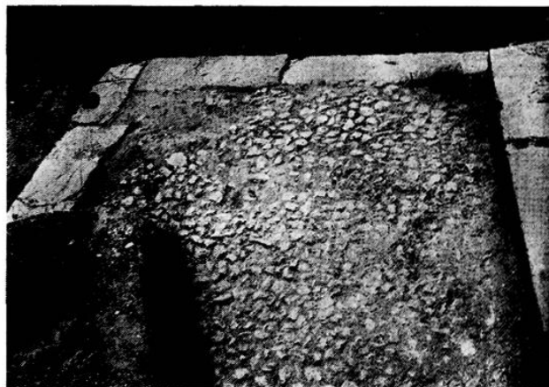
Fig. 16. Bâtiment à abside : sol du vestibule.
