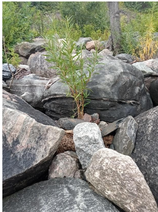
Fig. 2 : Plant de saule inséré dans les enrochements à l'aide d'une petite pochette de géotextile. Plage Jacques Cartier. Crédit : C. Moreau
