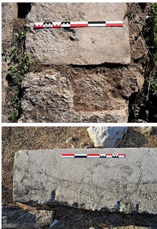
Fig. 12-13. Blocs du 1 er degré de la krépis K au centre de la base (la flèche indique la transition entre la zone avec traces d'outil à dents et la zone érodée).
