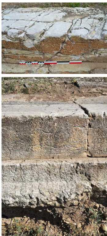
Fig. 8-9. Détails de la différence d'érosion sur les degrés de la krépis K.
