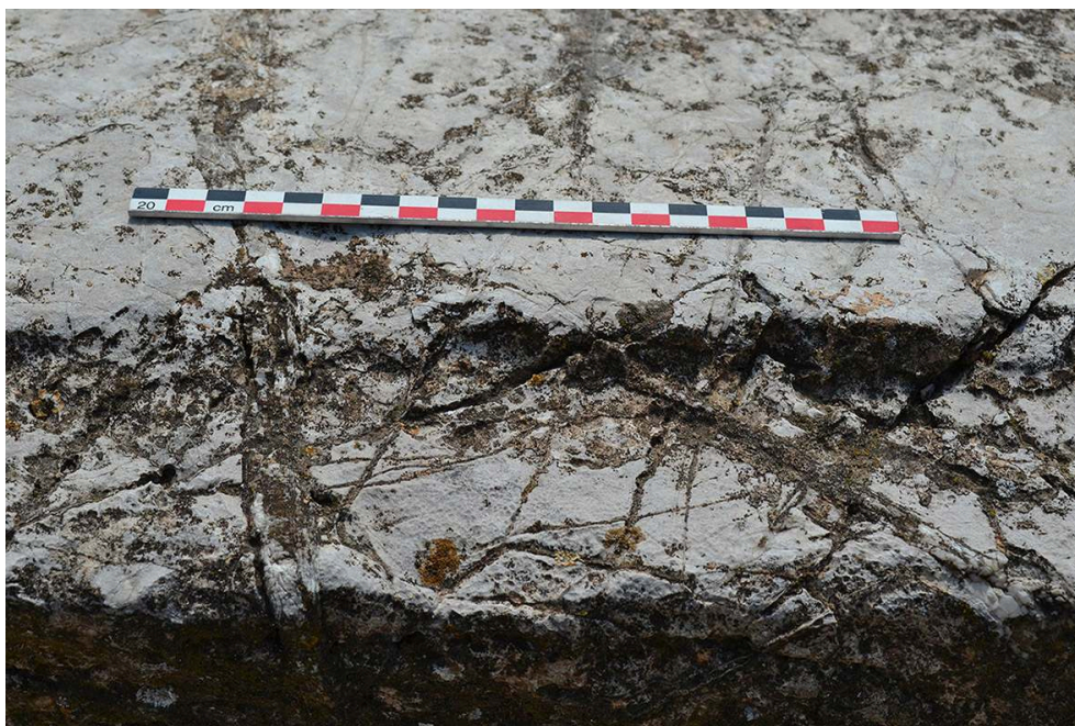
Fig. 6. Détail du 2 e degré de la krépis K : emplacement du joint entre deux blocs du stylobate.
