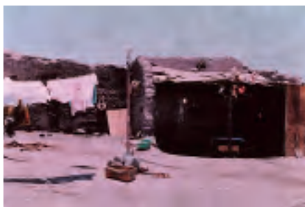
Figura 172. Precaria vivienda de mariscadores, adosada a los antiguos muros de adobe, destruidos por el maremoto y salida de mar de 1867.
