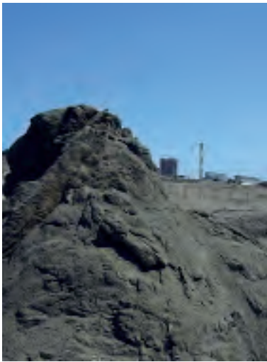
Figura 98. Planta de CELTA y su central termoeléctrica en Puerto Patache, visible detrás del montículo rocoso del primer plano. Su chimenea expele sin cesar una estela de humo tóxico que se dirige hacia el norte, exactamente donde se sitúan las caletas de pescadores de Cñaño, Chanavayita, Caramucho y Los Verdes (foto de Horacio Larrain, abril de 2009).
