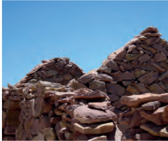
Figura 73. Techumbre a dos aguas en fuerte ángulo. La habitación estuvo primitivamente techada con gruesas capas de paja brava o ichu ( Stipa ichu ) (foto de Horacio Larrain).
