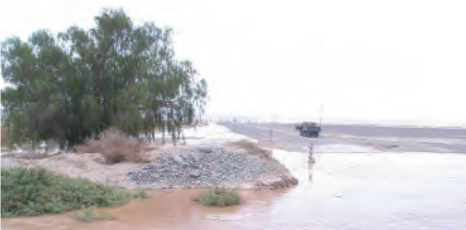
Figura 125. La enorme cantidad de agua que se acumula por meses, tras un aluvión, suele cortar las carreteras e impide el paso de vehículos. En algunos sectores, se forman pozas o lagunillas que sobreviven durante varios meses antes de secarse por completo (foto de Horacio Larrain, marzo de 2004).
