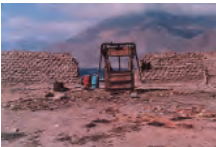
Figura 173. Muros de adobe aún enhiestos de las antiguas construcciones en el pueblo de Cobija, totalmente destruido por el terremoto y salida de mar del año 1867.
