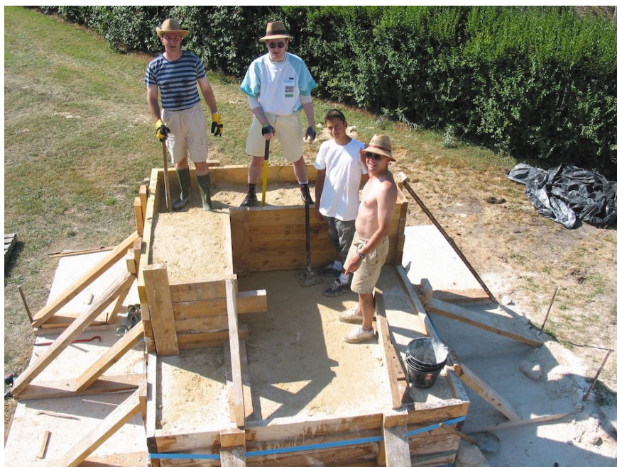
Figure 2: Equipe de damage des blocs dans les coffrages de bois en train de damer une pierre de 1,5 tonne.
