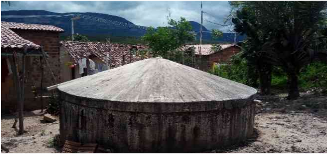
Imagem 5 – Cisterna de alvenaria
