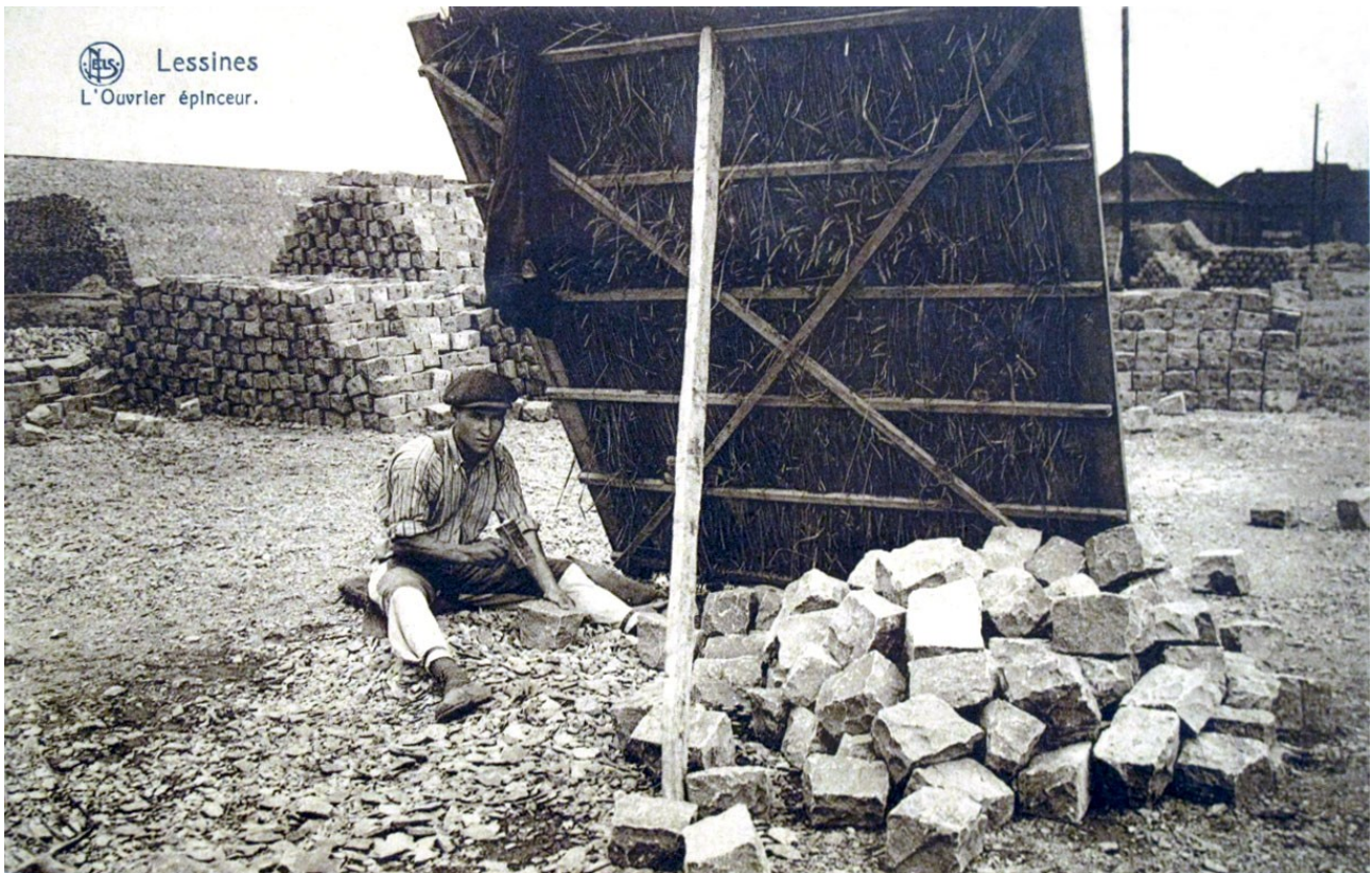
Carte postale des années 1900 représentant un épinceur (ouvrier spécialisé dans la taille de pavés), travaillant dans la carrière de Lessines en Belgique. La fabrication des pavés produit des déchets de taille moyenne à petite, entre 1 à 10 cm, visibles au pied de l'épinceur. Carte postale issue d'une collection privée.
