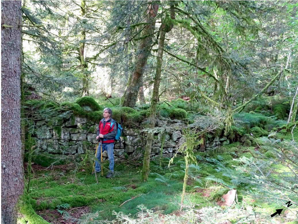
Haut-du-Them-Château-Lambert La Pransière ruine d'une maison d'habitation
