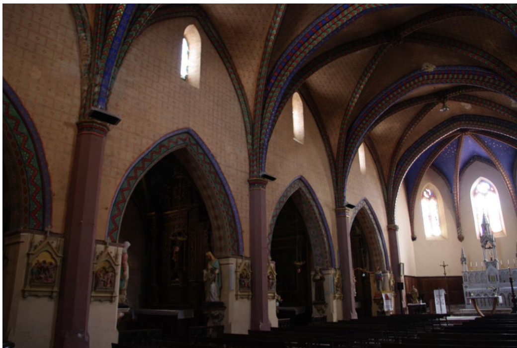
Fig. 11 : Monferran-Savès, église paroissiale, vue intérieure vers l'est (Cl. C. Balagna)
