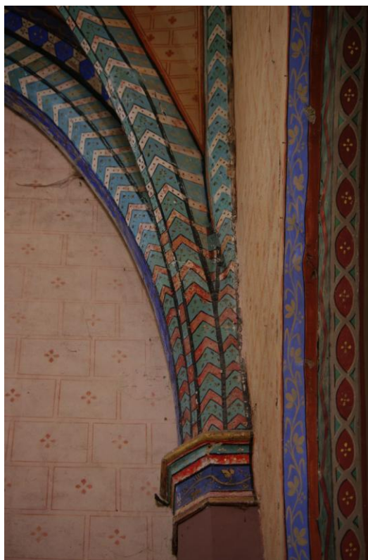
Fig. 14 : Monferran-Savès, église paroissiale, pilier d'angle nord-ouest et détail du voûtement (Cl. C. Balagna)
