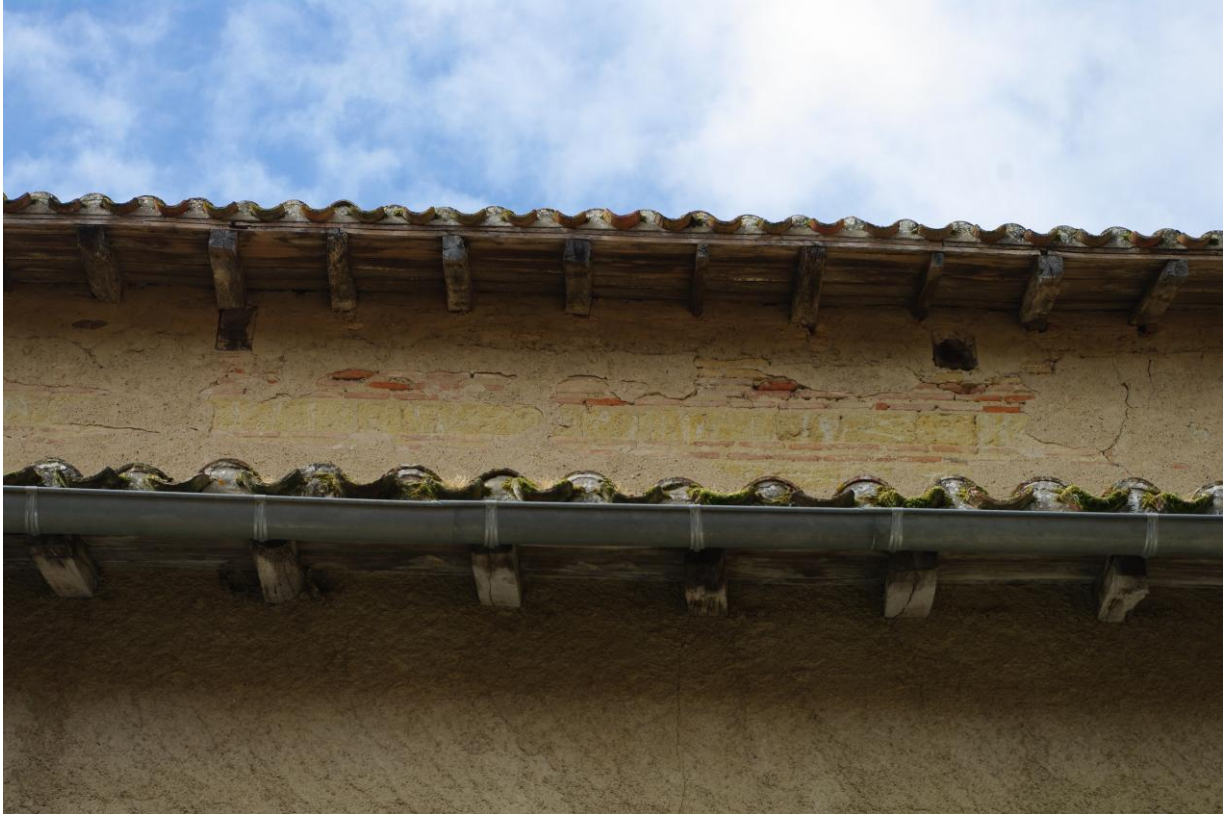
Fig. 17 : Monferran-Savès, église paroissiale, élévation nord de l'église, détail (Cl. C. Balagna)
