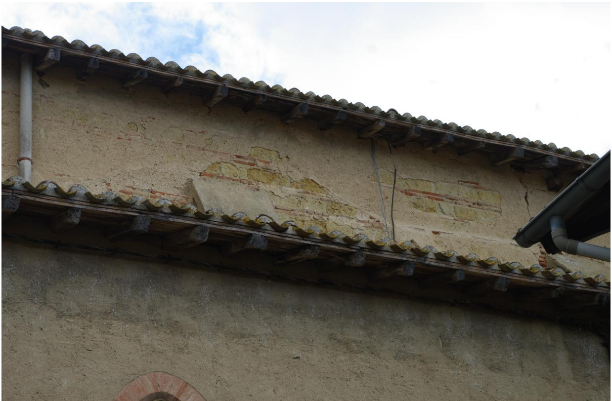
Fig. 18 : Monferran-Savès, église paroissiale, élévation sud de l'église, détail (Cl. C. Balagna)
