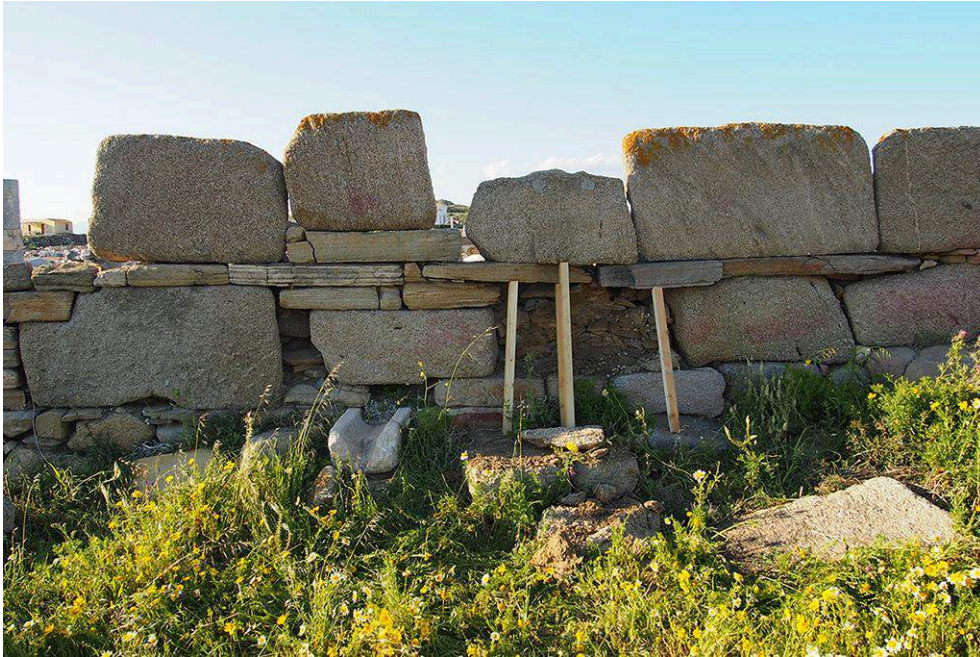
Fig. 11. Oikos des Naxiens : étaieement du mur sud.
