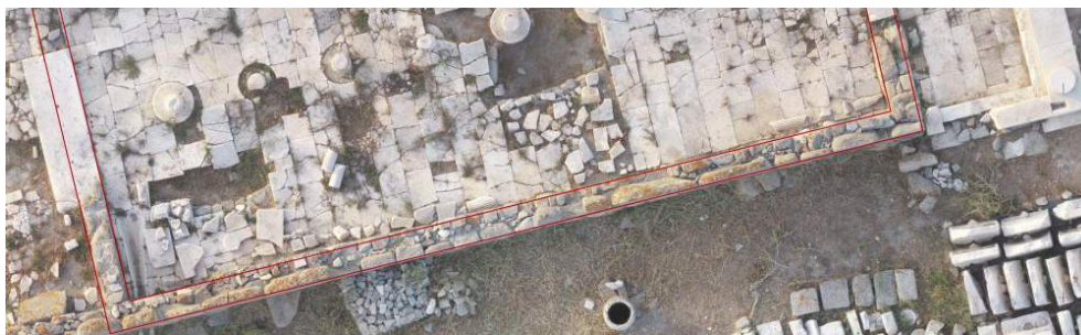
Fig. 5. Oikos des Naxiens : bombement du cours intérieur du mur sud d'après l'orthophotographie de l'état actuel.
